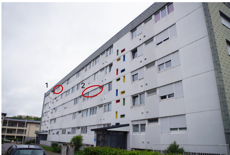
Figure 2. Localisation des contacts de martinet noir sur la facade ouest du bâtiment 12 (© VERDI). 1 : Aterrissage d'un martinet noir à proximité de la parabole. 2 : Visite à deux reprises par des individus de martinet noir.
