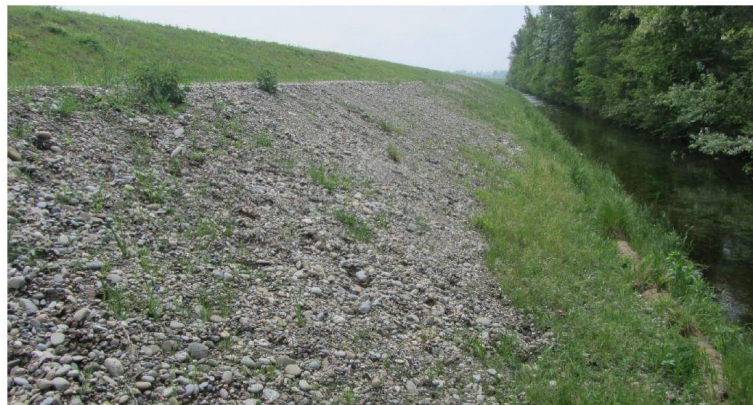
Figure 11 : Photo du tronçon concerné par les travaux lors du suivi post-travaux réalisé en mai 2018 (Source : EDF)
