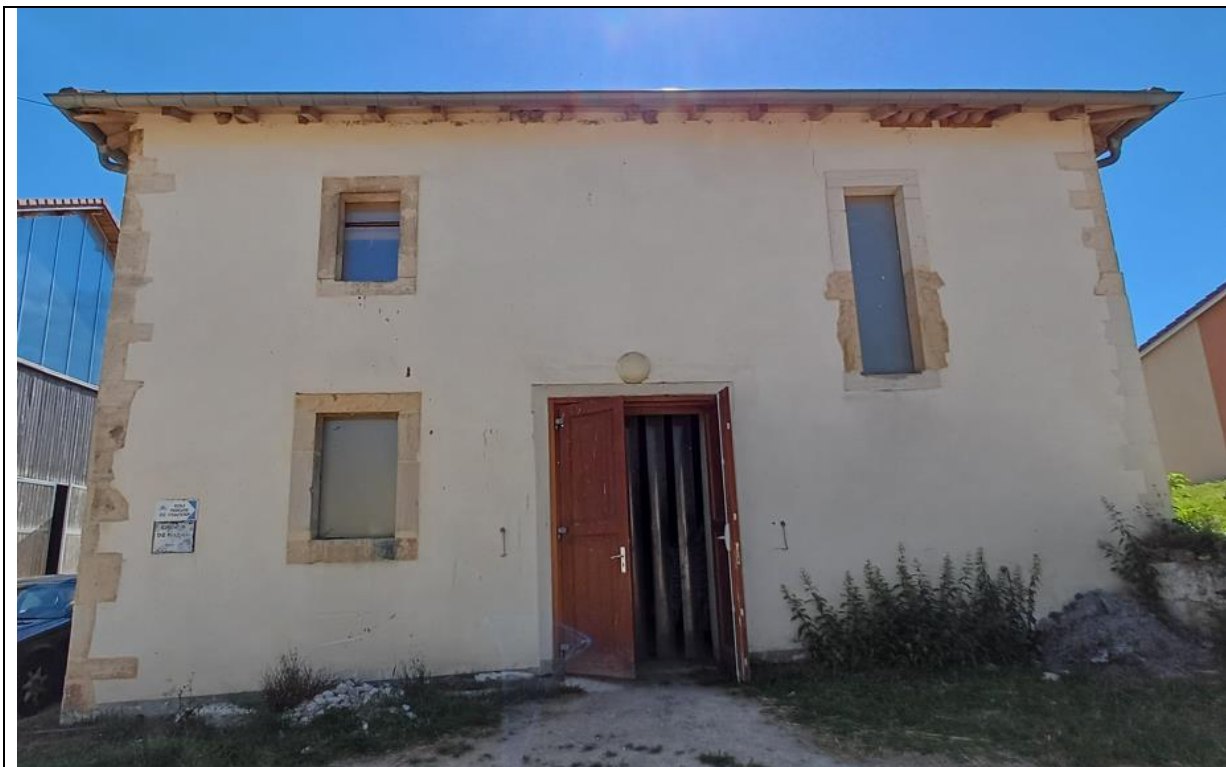
Façade nord-est avec 4 nids artificiels pour Hirondelle de fenêtre
