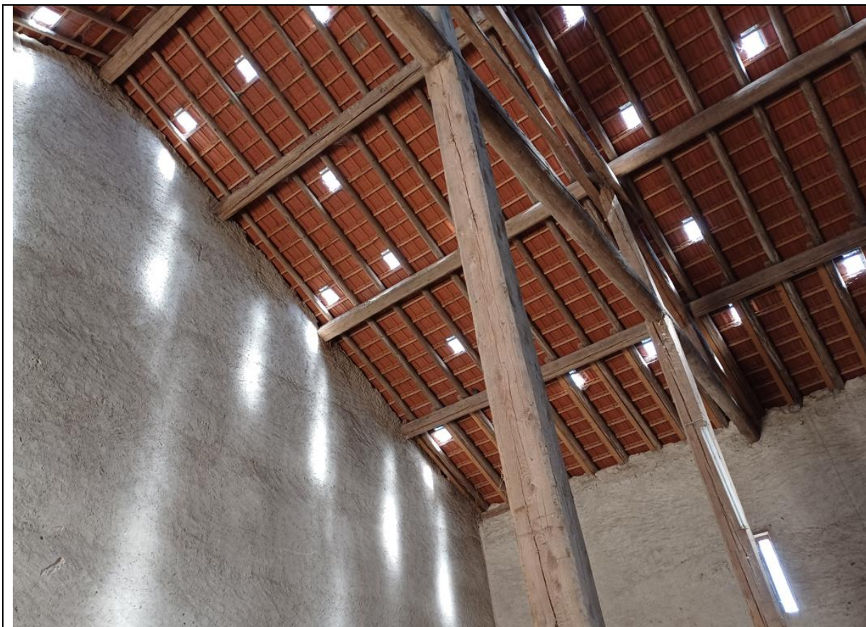
Comble situé au-dessus de l'écurie
