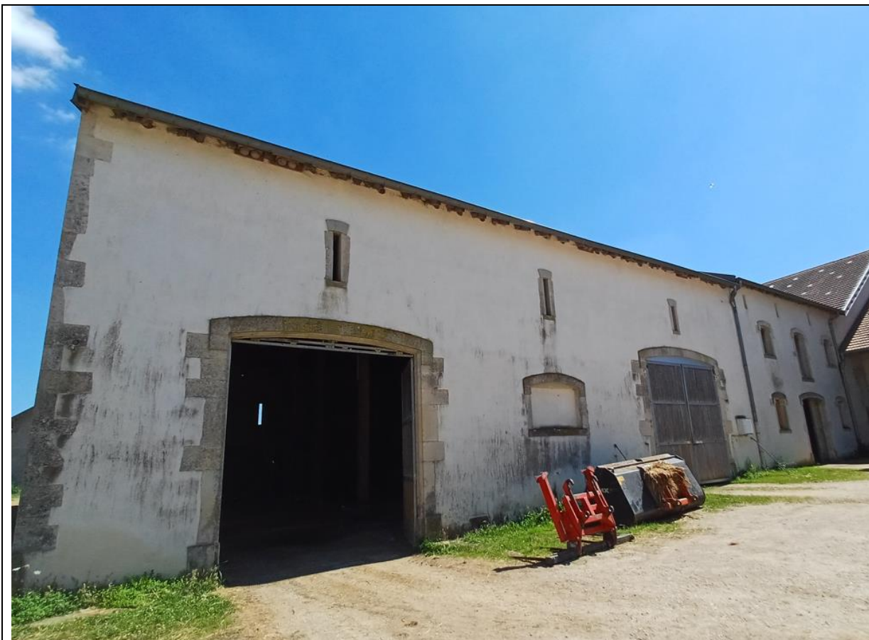
Façade nord-ouest avec 8 nids artificiels pour l'Hirondelle de fenêtre sur le bâtiment B002
