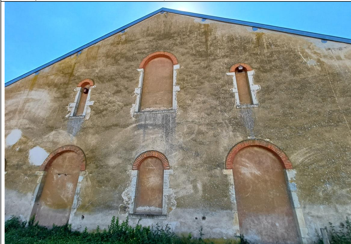
Pignon nord-ouest avec deux nichoirs pour passereaux sur le bâtiment B002
