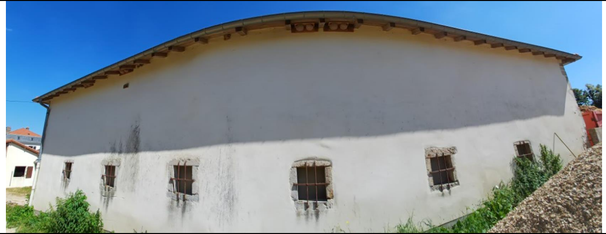
Façade nord-ouest avec 8 nids artificiels pour l'Hirondelle de fenêtre
