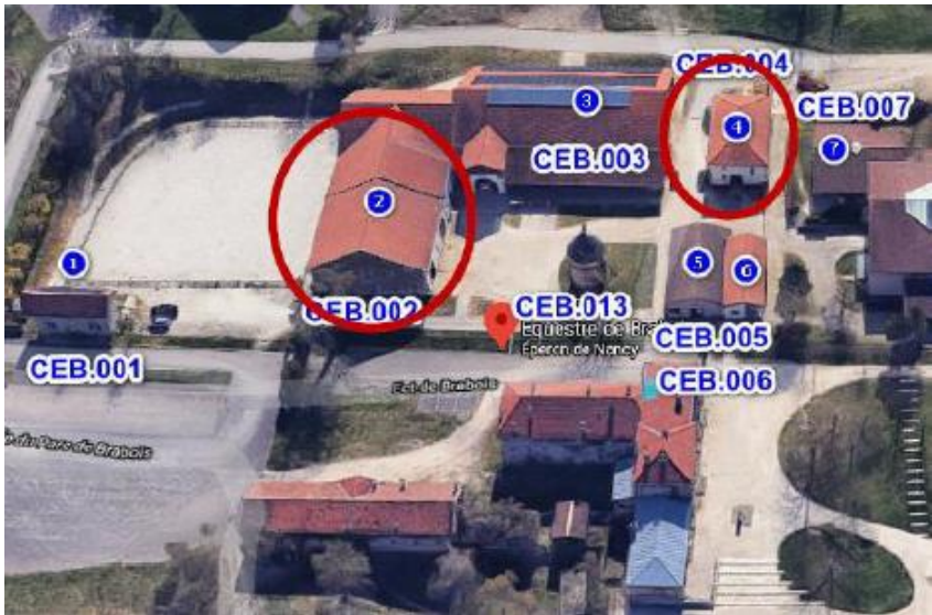
Figure 3 : Vue aérienne des bâtiment B002 et B004 (emprise rouge) (Source : CD54)
