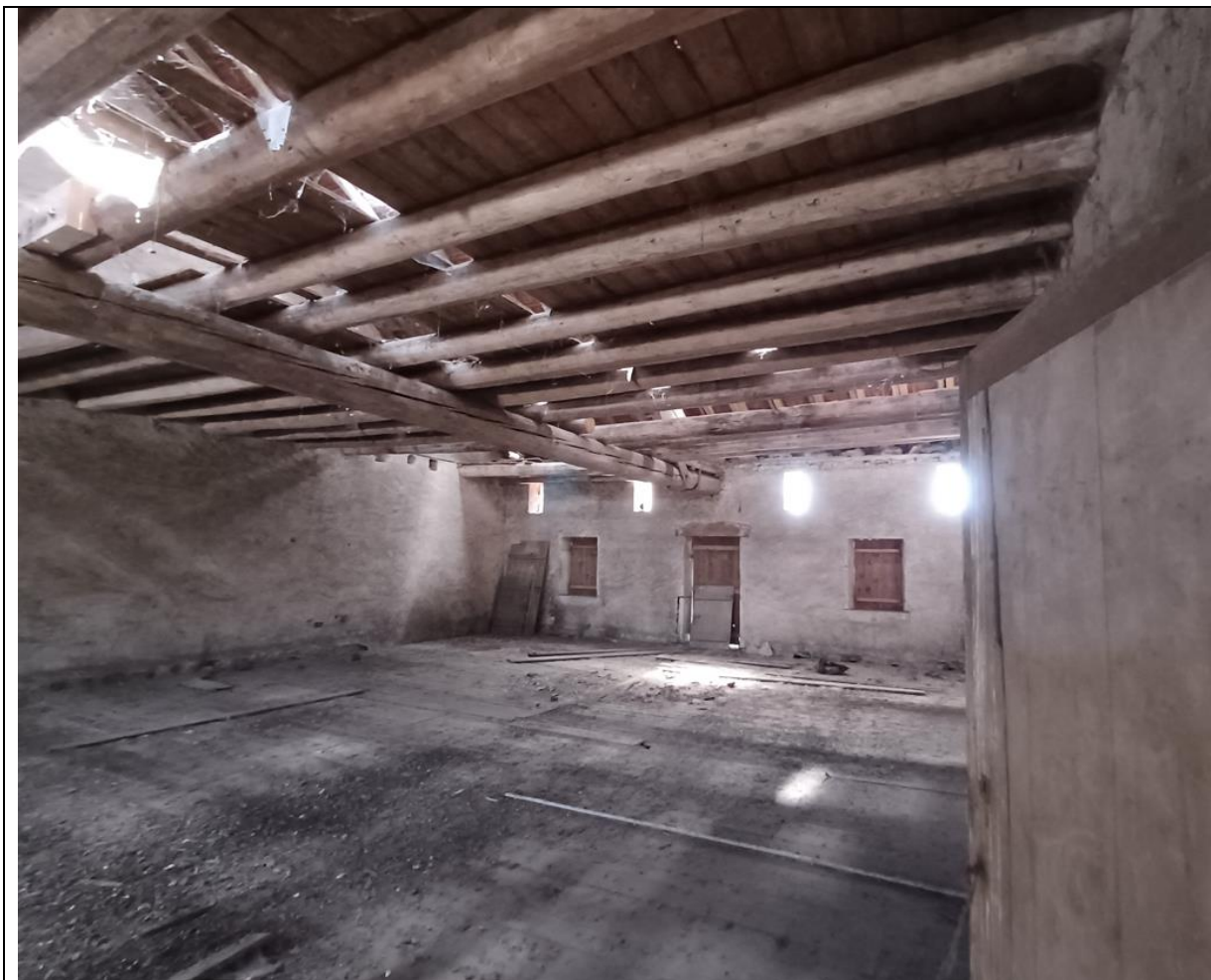
1 er étage du bâtiment B002 situé au-dessus de l'écurie
