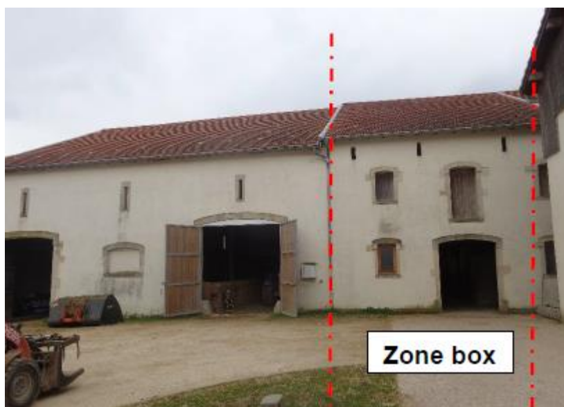
Figure 7 : Localisation de la petite écurie à poneys avec une vue de la façade nord-ouest
