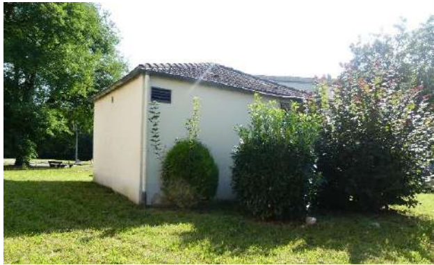
Figure 59 : Bâtiment technique au centre de l’aire d’étude, © EODD 2024
