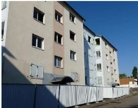
Figure 56 : Aspect extérieur du bâtiment à démolir, © EODD 2024
