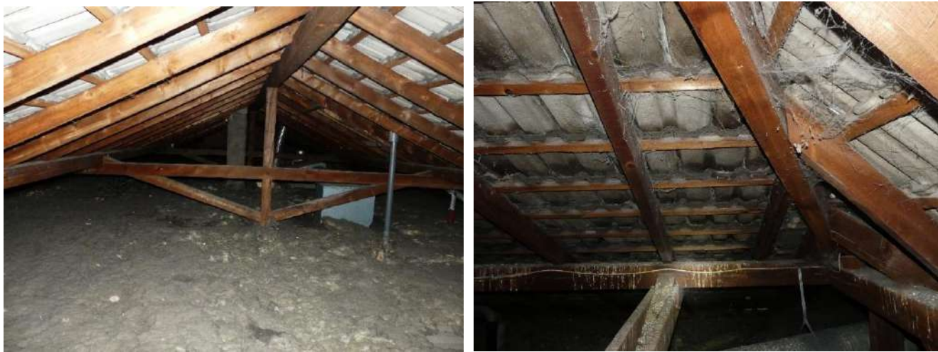
Figure 58 : Combles du bâtiment à rénover, © EODD 2025
