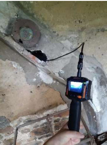
Figure 16 : Vérification d'une cavité à l'endoscope © EODD, 2023
