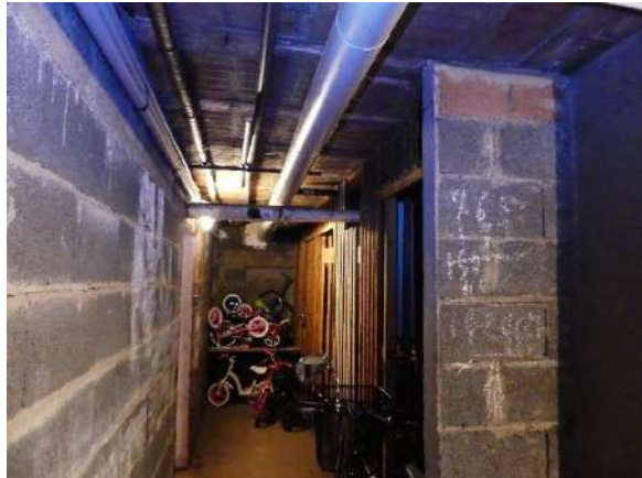
Figure 57 : Aspect des caves encore utilisées © EODD 2024
