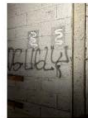
Mur parpaing du bâtiment d'intérêt moyen au point 3
