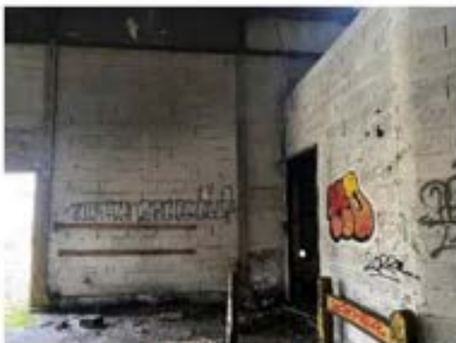
Mur parpaing du bâtiment d'intérêt moyen au point 3
