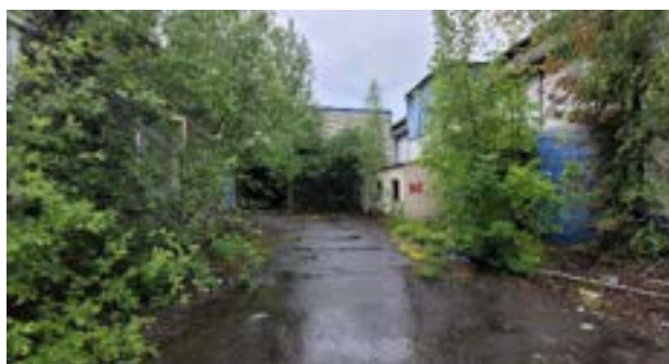
Végétation se développant entre les bâtiments
