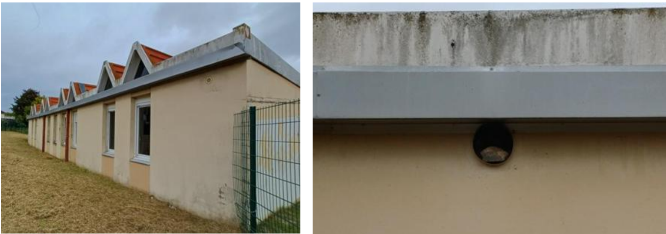
Figure 15 : Façade ouest du bâtiment (gauche), localisation du nid au sein du conduit (droite), © LADT, 2025
