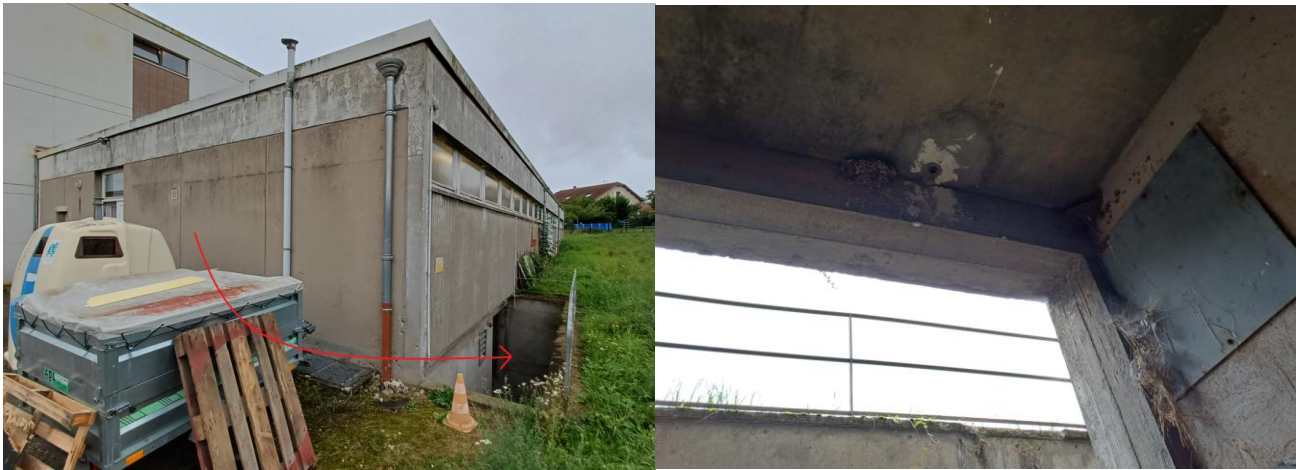
Figure 11 : Escaliers menant à la chaufferie, et vue sur deux nids d'Hirondelle rustique, © LADT, 2025
