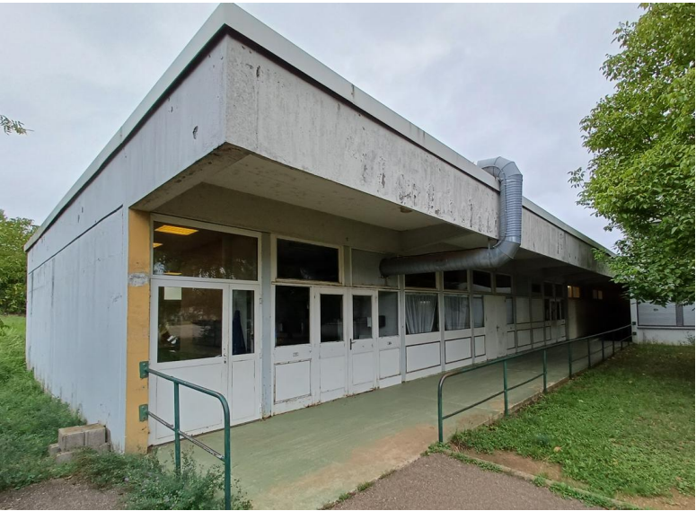
Figure 12 : Préau sur la façade sud de la demi-pension, © LADT, 2025
