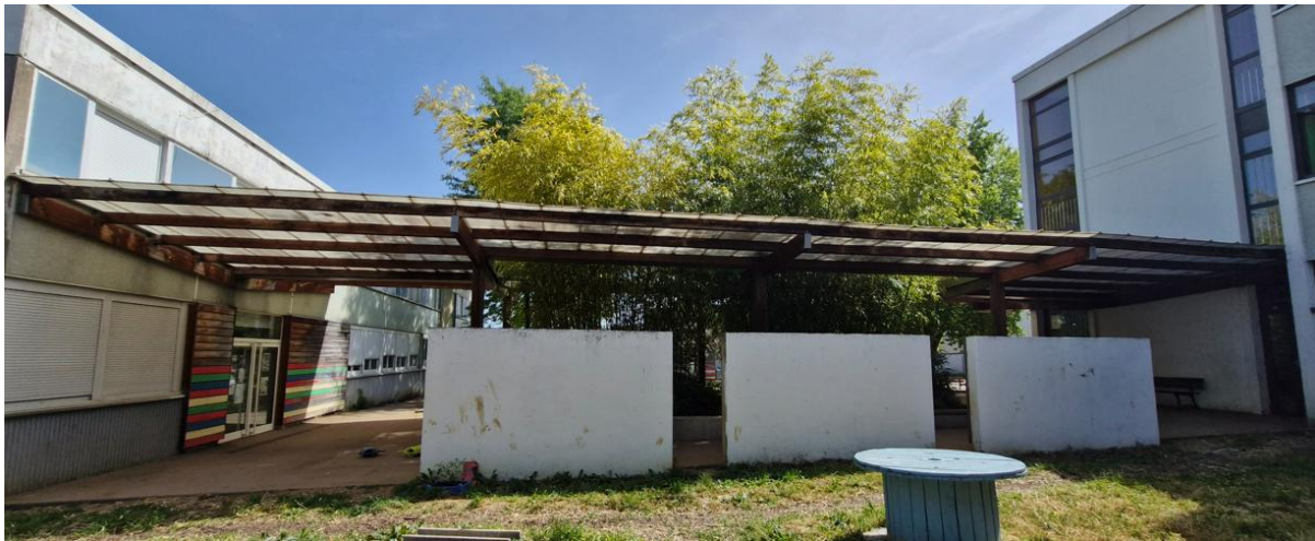
Figure 17 : Vue générale du préau reliant l'externat et l'administration, © EODD, 2026
