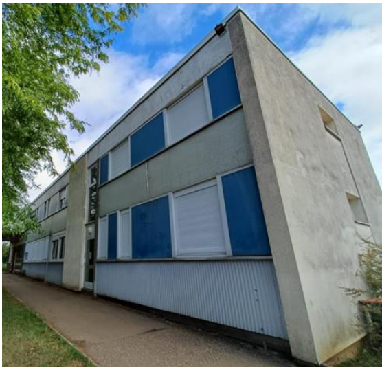
Figure 16 : Vue général des façades ouest et sud de l'administration, © LADT, 2025
