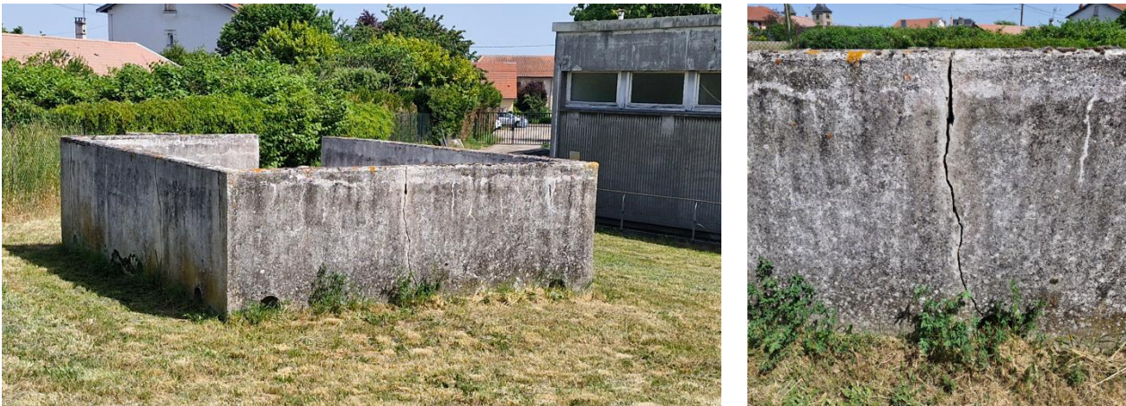
Figure 23 : Murets favorables au Lézard des murailles (gauche), et fissures favorables (droite), © EODD 2026
