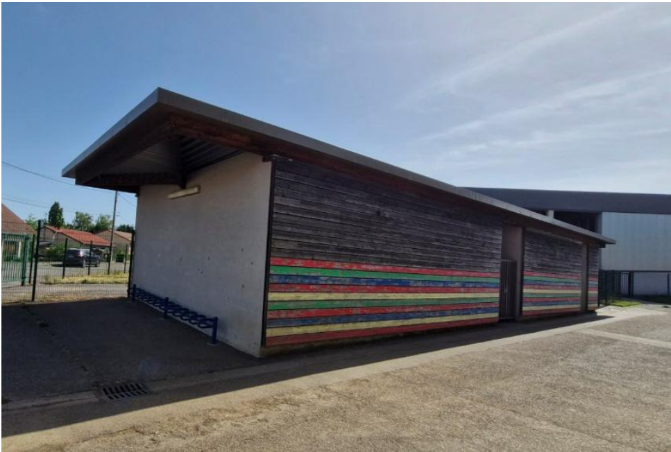
Figure 18 : Vue générale des garages du collège Val de Seille, © EODD, 2026
