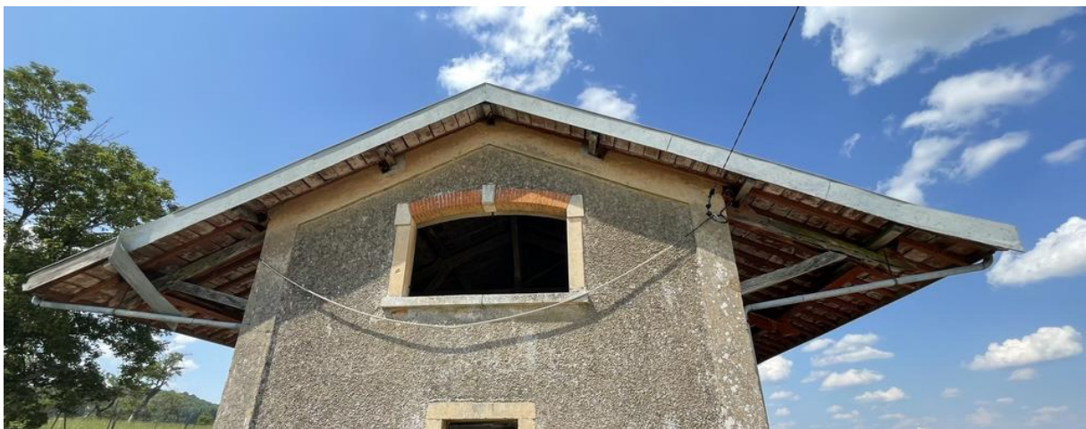
FIGURE 3 : TOITURE VUE DEPUIS LA FACE SUD DU BATIMENT EXPERTISE A VANDELEVILLE (54)
