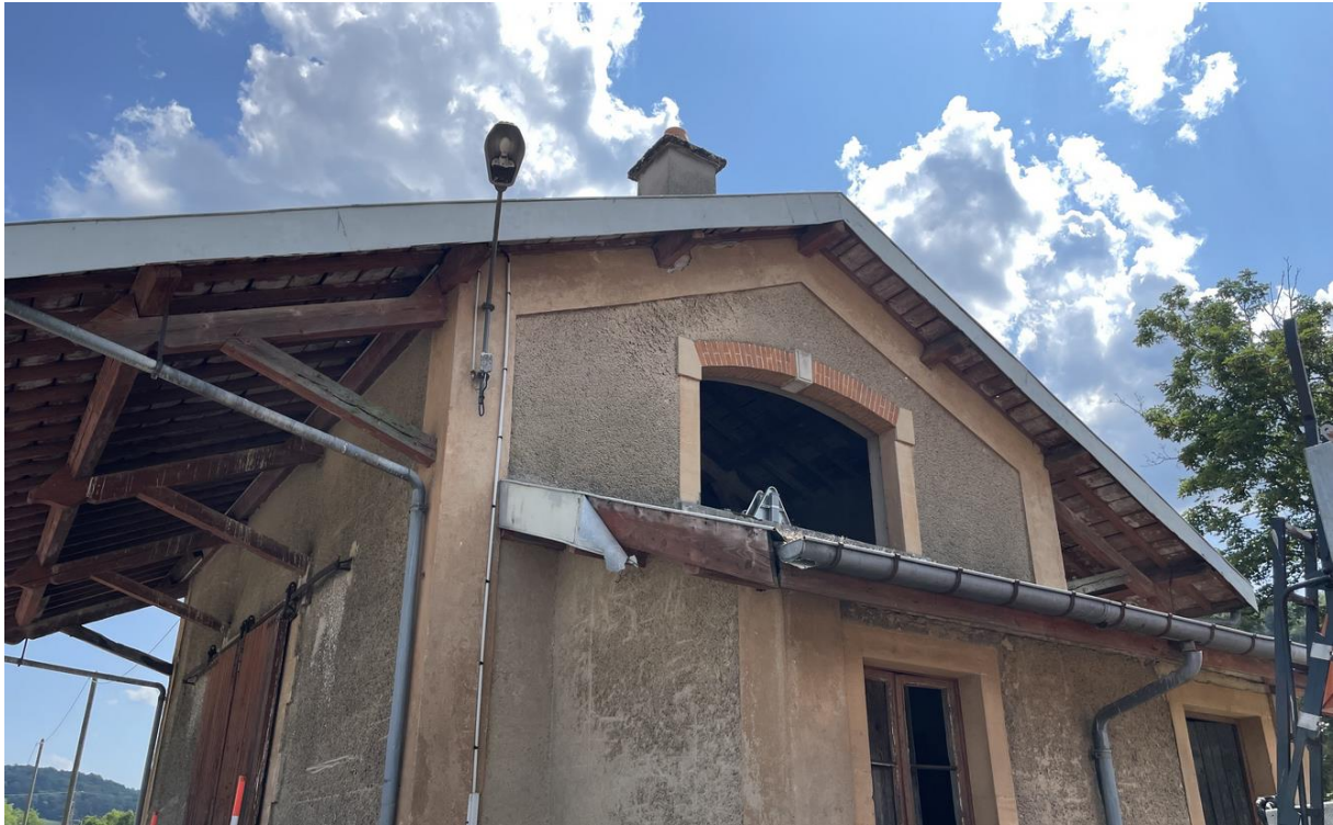
FIGURE 4 : TOITURES VISIBLES DEPUIS LA FACE NORD DU BATIMENT EXPERTISE A VANDELEVILLE (54)
