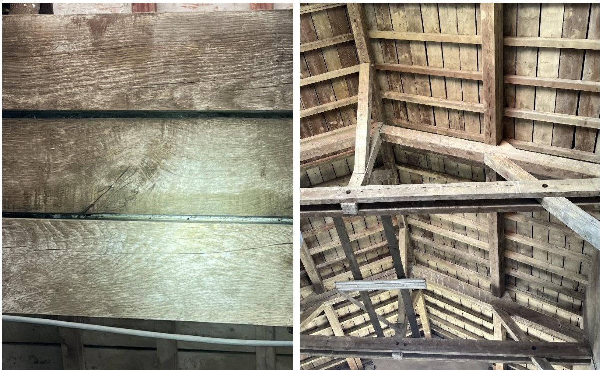
FIGURE 6 : ESPACES FAVORABLES ENTRE LES TRAVERSES DE LINTEAU (A GAUCHE) ET AU NIVEAU DE LA CHARPENTE (A DROITE) DU BATIMENT EXPERTISE A VANDELEVILLE
