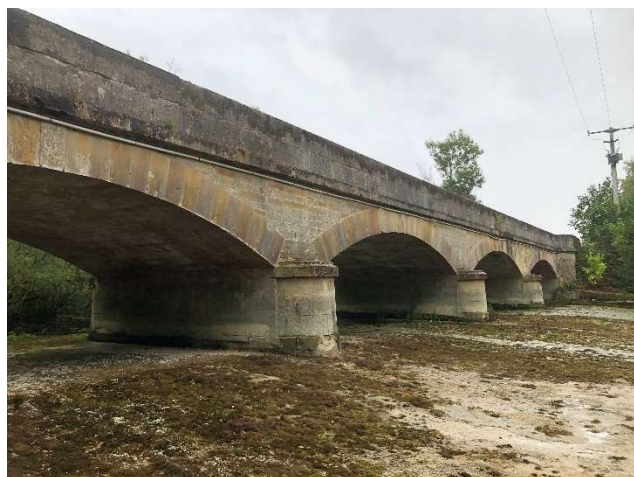
Vue sur l'aval du pont depuis la rive droite
