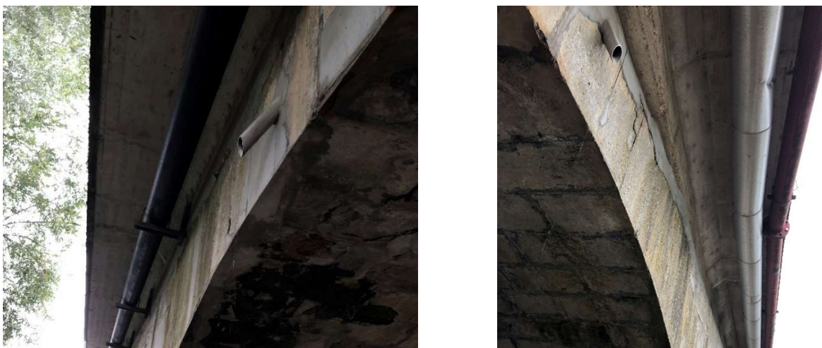
Vues sur les drains des tympan
