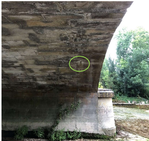
Vue sur le drain aval vide
