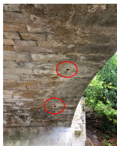
Vue sur les drains amont occupés
