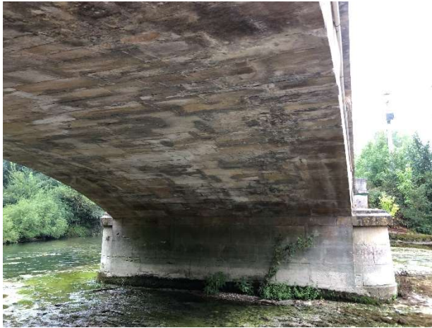
Vue sur l'arche n°2
