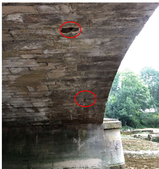
Vue sur les drains aval occupés
