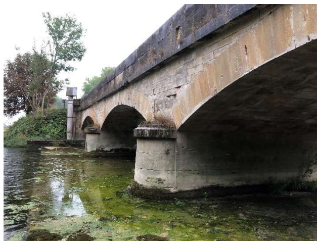
Vue sur l'amont du pont depuis la rive droite
