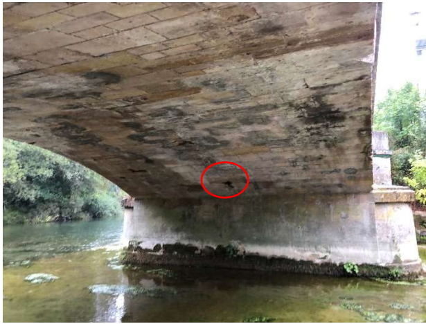
Vue sur l'arche n°3 et la cavité milieu rive gauche occupée
