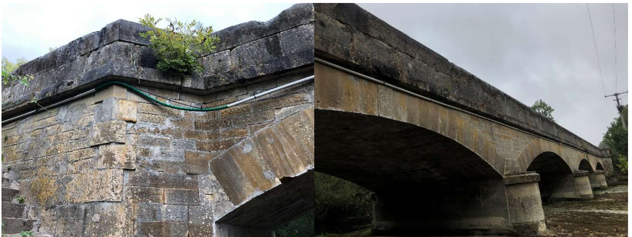
Vues sur le tympan aval rejointoyé
