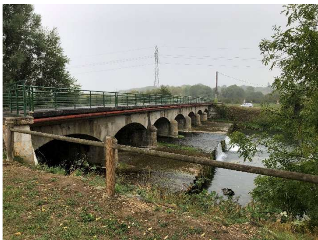
Vue sur le pont depuis la rive droite
