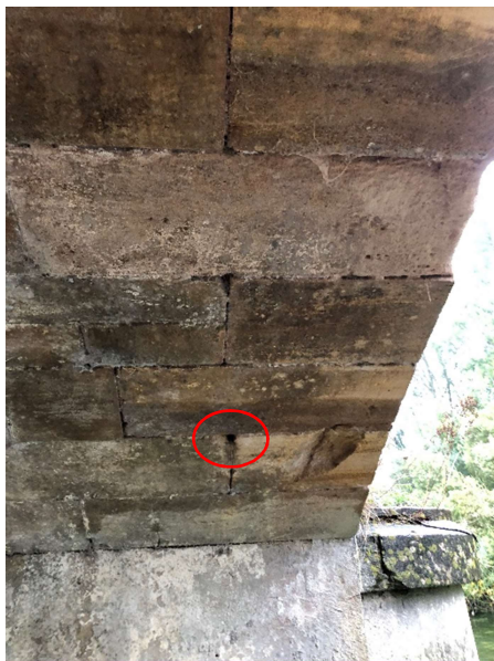
Vue sur le drain amont rive droite occupé
