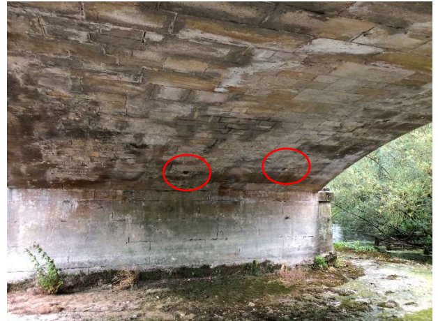
Vue sur la cavité et le drain amont rive droite
