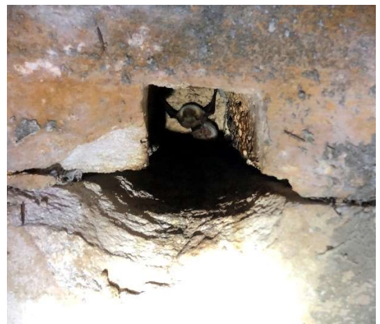
Vue sur la cavité occupée en rive droite
