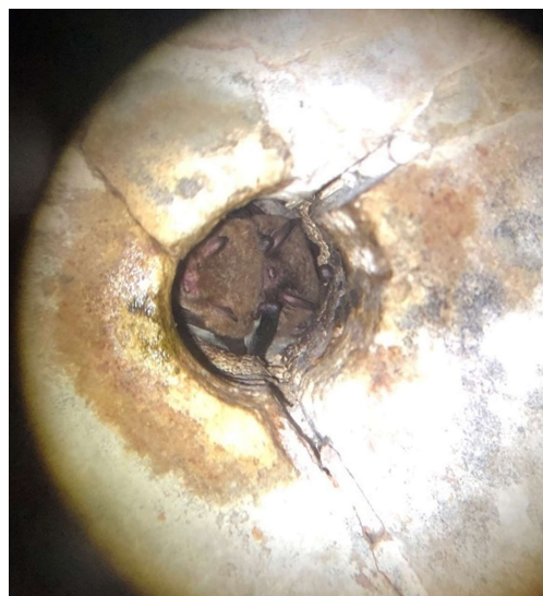
Vue sur les murins du drain central amont
