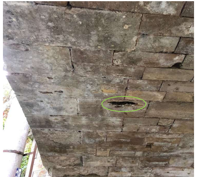
Vue sur la cavité amont vide mais qui présente des traces de guano
