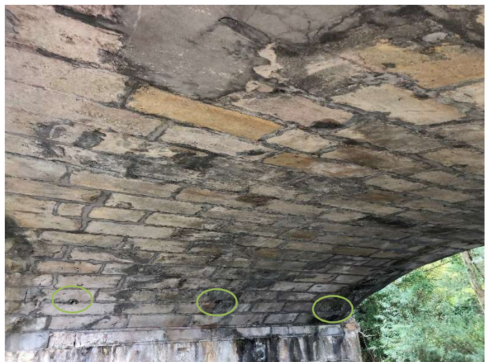
Vue sur l'arche n°2 avec les drains tubés vides
