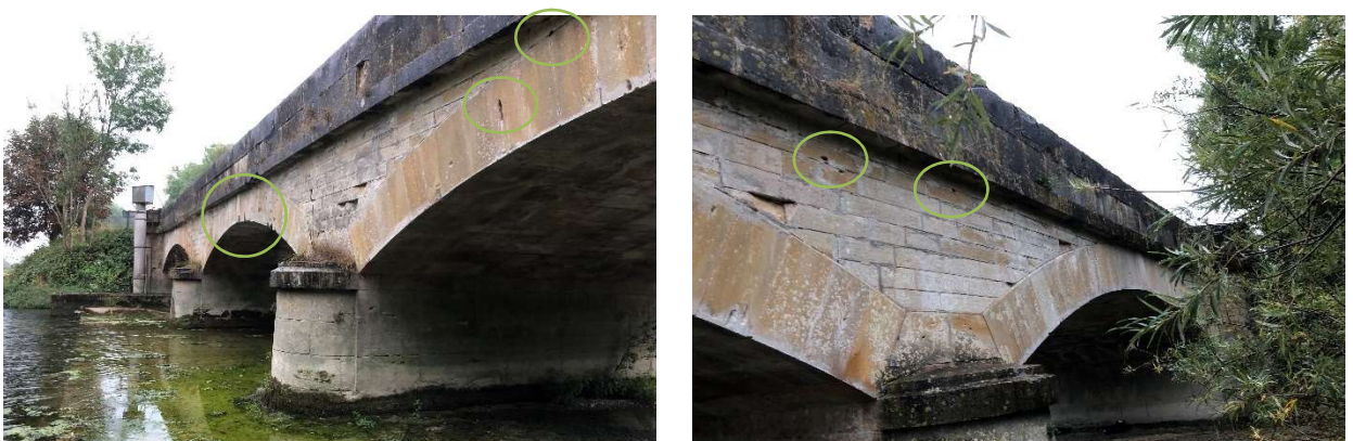
Vues sur le tympan amont présentant des cavités
