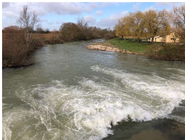
Vue sur l'aval du pont le 11/02/2020
