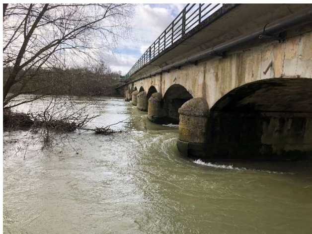
Vue sur l'amont du pont le 11/02/2020
