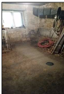
Cave arrière gauche, pose d'un siphon de sol avec raccordement dans le regard de la pompe vide-cave
