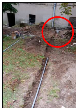
Cave arrière gauche, pose d'un siphon de sol avec raccordement dans le regard de la pompe vide-cave
