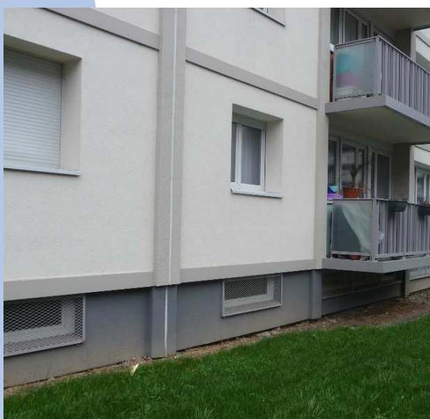
Figure 6 : modénatures de façade avec éléments d'ITE, vue après travaux (photo Cerema)
