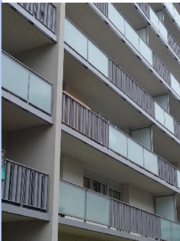
Figure 5 : traitement des balcons filants, bâtiment rue de Palerme, vue après travaux (photo Cerema)
