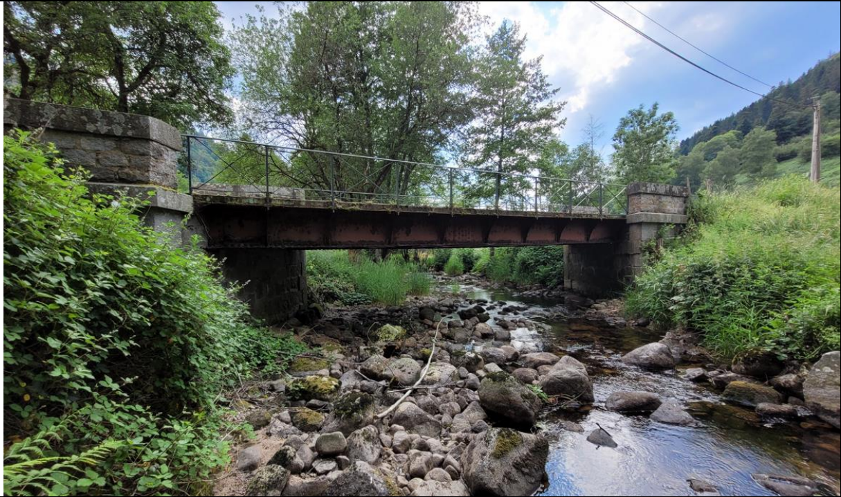
Vue amont du tablier
