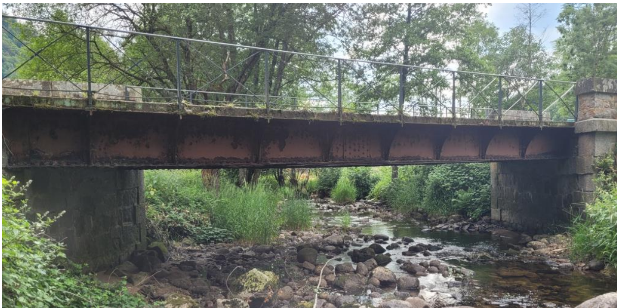
Figure 3 : Pont des Truches (pont à poutres sous chaussée) à Rochesson
