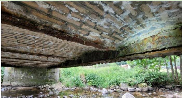
Poutrelles métalliques soutenant les voutains en briques
