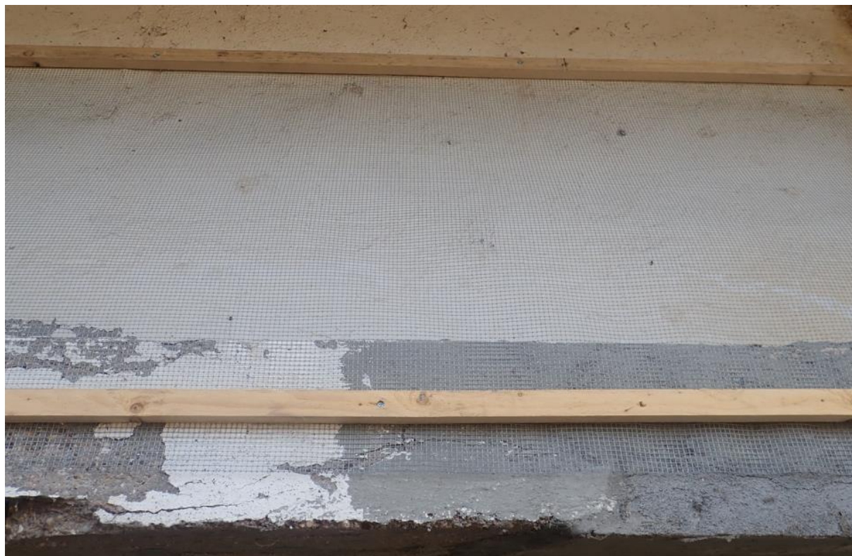
Figure 9 : Exemple de neutralisation d'un ouvrage d'art via un "grillage" rigide à mailles carrées de 5 mm x 5 mm empêchant l'avifaune ou la chiroptérofaune de se retrouver prisonnier du dispositif de neutralisation
