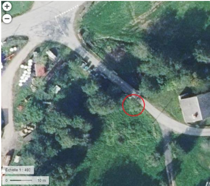
Vue aérienne de l'arbre devant subir une coupe en prévision des travaux de remplacement de l'ouvrage d'art
