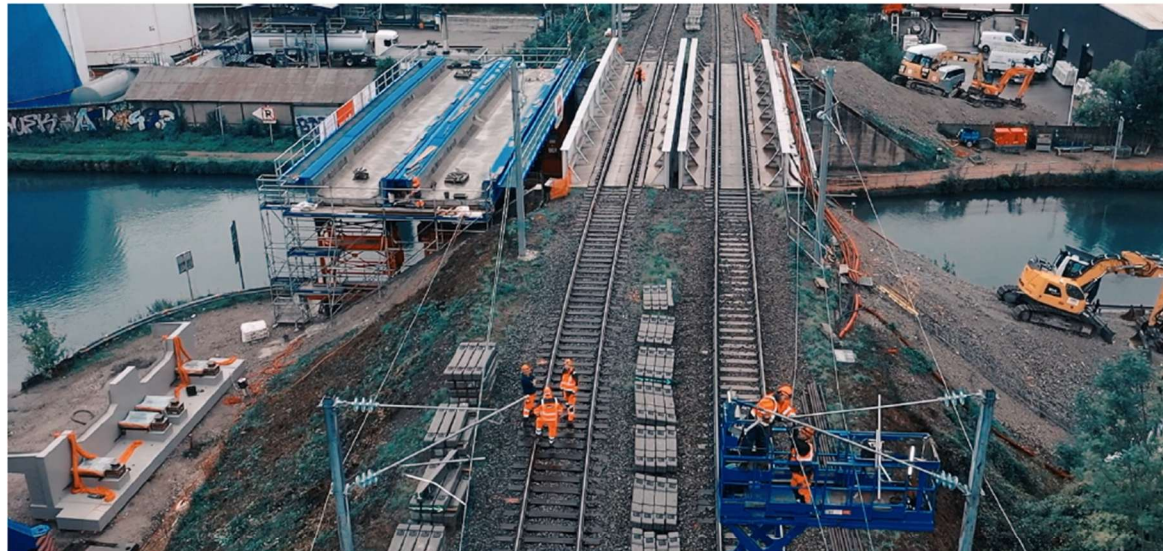
7.1- OCP : Dépose des voies sur l'ouvrage + Dépose des tabliers existants + Démolition des sommiers existants
