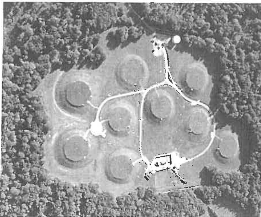
Photo SFDM : vue aérienne du parc
