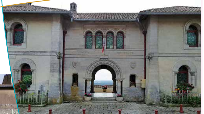
Entrée mairie donnant accès à la plateforme
