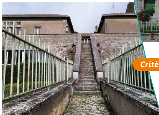
Escaliers vu depuis la plateforme
