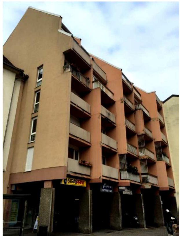
Figure 2 : la façade avant travaux (photo : M-associés architectes)
