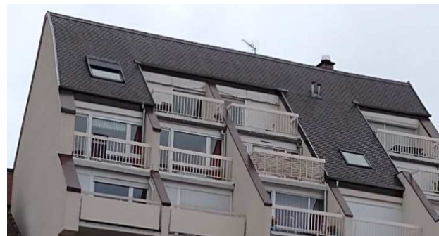
Figure 9 : terrasses et toiture après rénovation (photo Dreal)
