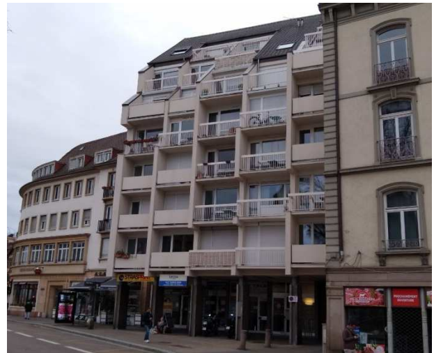
Figure 8 : l'immeuble rénové dans son contexte (photo Dreal)
