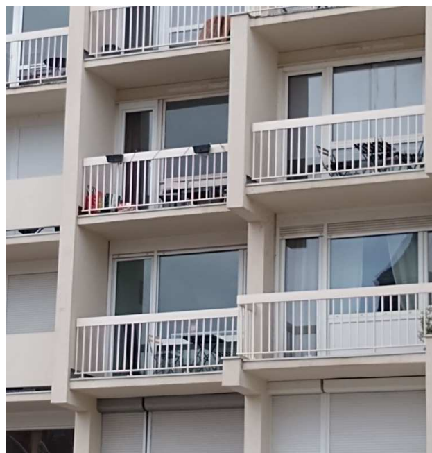
Figure 10 : les balcons après rénovation (photo Dreal)
