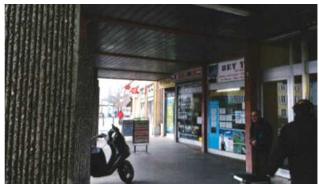
Figure 3 : passage couvert et commerces du RdC (photo : M-associés architectes)
