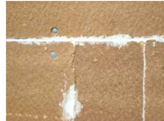
*Joints silicone entre panneaux de fibre de bois*
