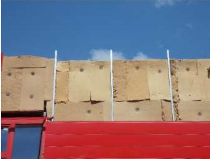
*Isolant non jointif et manquant*
