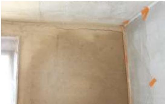
Enduits terre sur isolant paille : conditions capillaires et temps de séchage inappropriés
