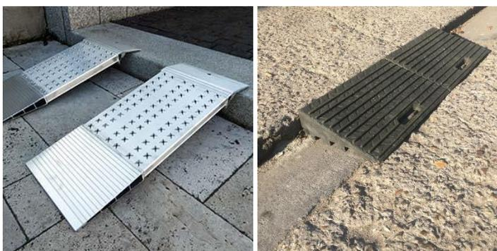
Figure 31 : Exemples de rampes de trottoirs
