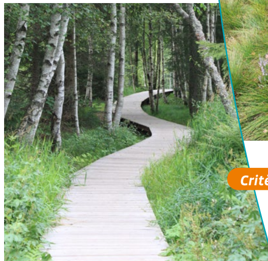
Aménagement piétonnier aux abords de la tourbière
