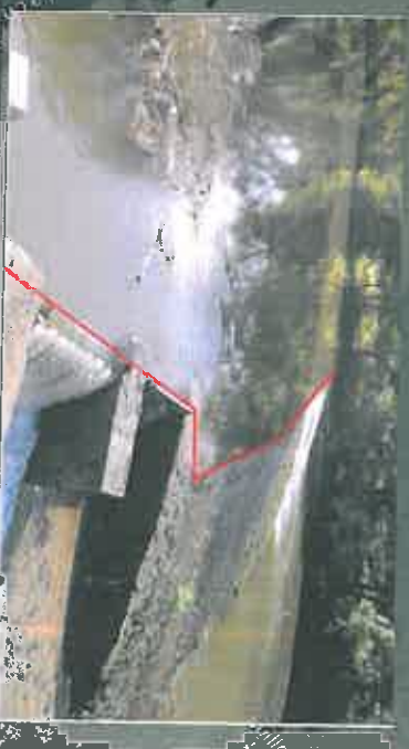
Seuil fixe, tracé de mise en place des ventelles pour rehausse du seuil fixe de 0,6m (19/09/2012)
