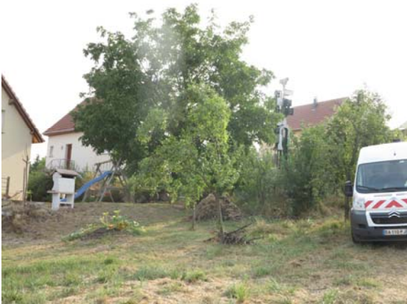
Photographie 22 – Vue du chantier
