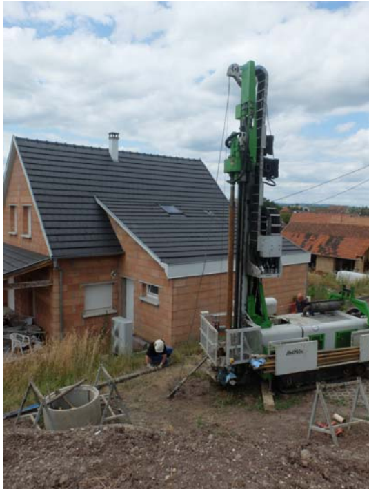
Photographie 10 – Vue du chantier sur le terrain de M. Kandel
