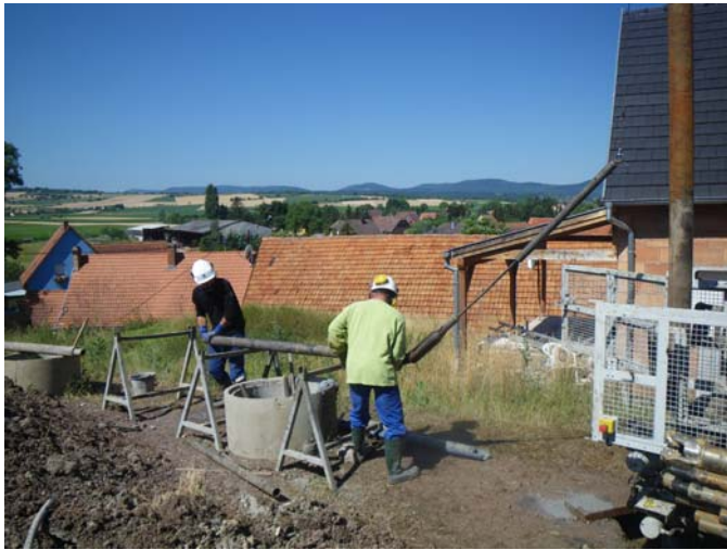
Photographie 8 – Remontée et ouverture du carottier à câble
