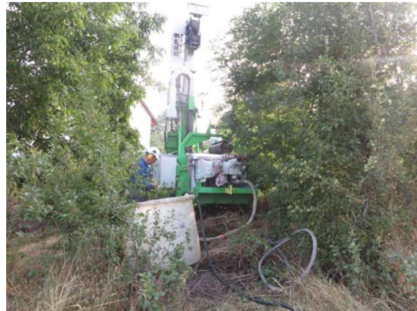
Photographie 21 – Vue du chantier
