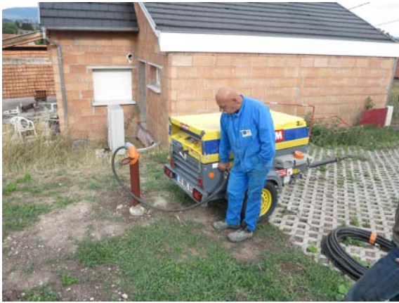
Photographie 29 – Mise en place du dispositif sur SC4
