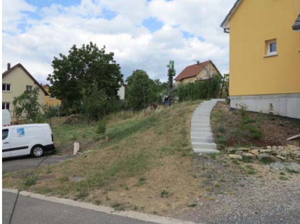
Photographie 17 – Vue du chantier
