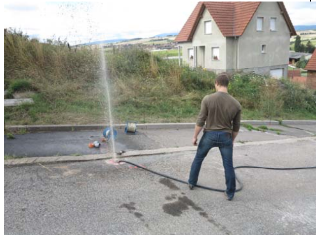
Photographie 30 – Air-lift sur SC5
