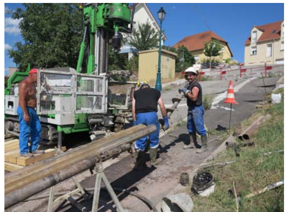
Photographie 13 – Forage de l'avant-trou
