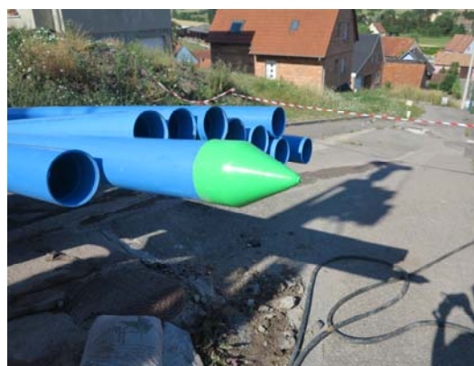
Photographie 4 – Vase à sédiment et tubes
