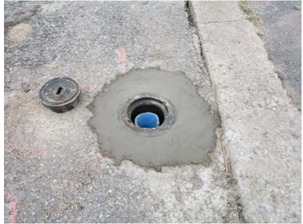
Photographie 15 – Vue du piézomètre SC5 terminé
