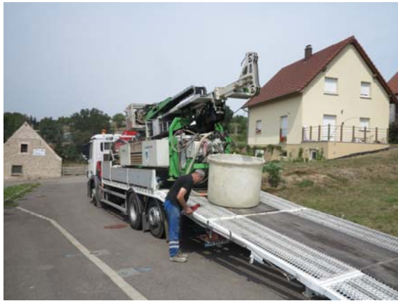
Photographie 20 – Déplacement de la foreuse
