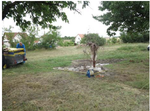
Photographie 32 – Air-lift sur SC7
