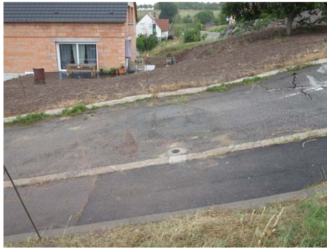
Photographie 16 – Vue du piézomètre SC5 terminé
