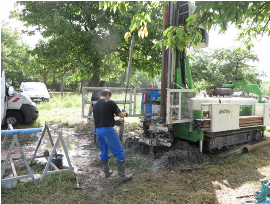
Photographie 19 – Vue du chantier
