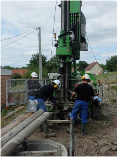
Photographie 6 – Tarière hélicoïdale pour forer l'avant-trou
