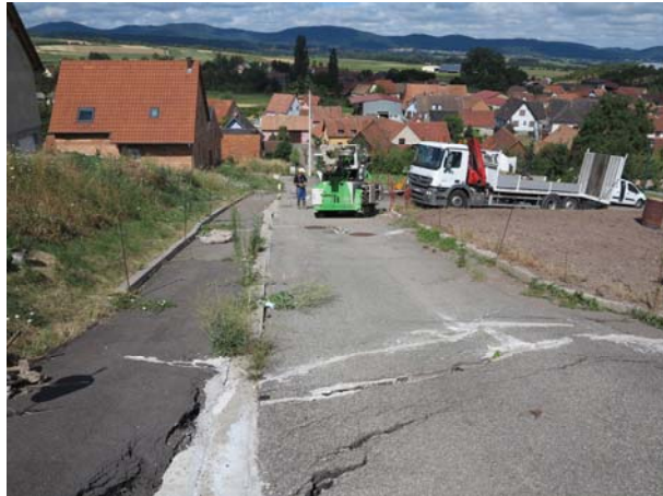
Photographie 12 – Déplacement de la foreuse
