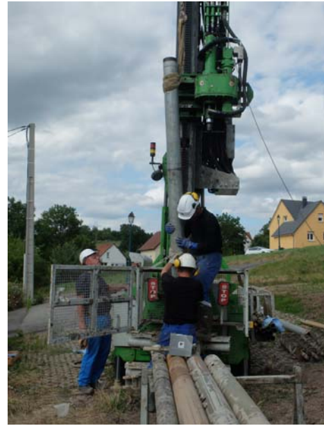
Photographie 7 – Descente des tubes d'avant-trou
