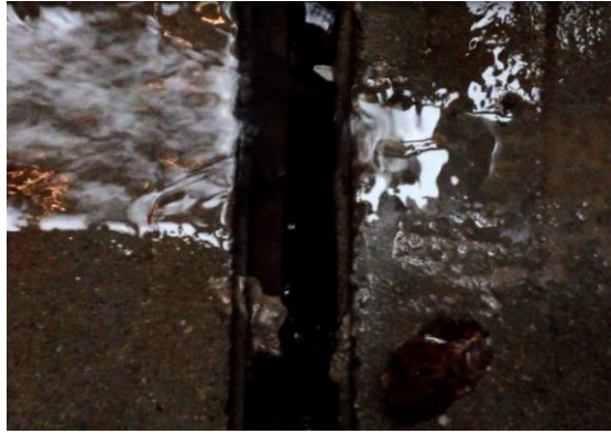
Figure 30 – Extrait d'une vidéo-amateur réalisée par un habitant montrant l'infiltration de la majeure partie du débit d'eau qui s'écoule dans la rigole de la placette en haut de l'impasse du Koelberg, vers les terrains (28 juillet 2012)
