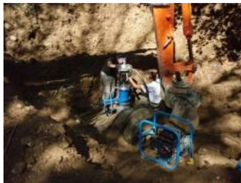
Mise en sécurité du puits du Chevillon
