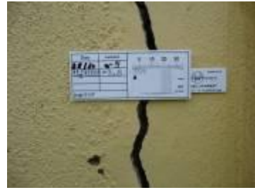
Fissurométrie sur un bâtiment d'Angevillers
