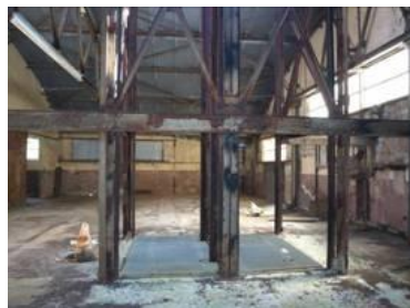
La grille du puits 2 à Audun le Tiche
