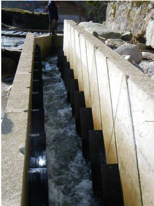
Figure 24 : Ralentisseurs plans sur la centrale des Meix Freiteux sur le Ventron (88) (photo : V. BURGUN – ONEMA)
