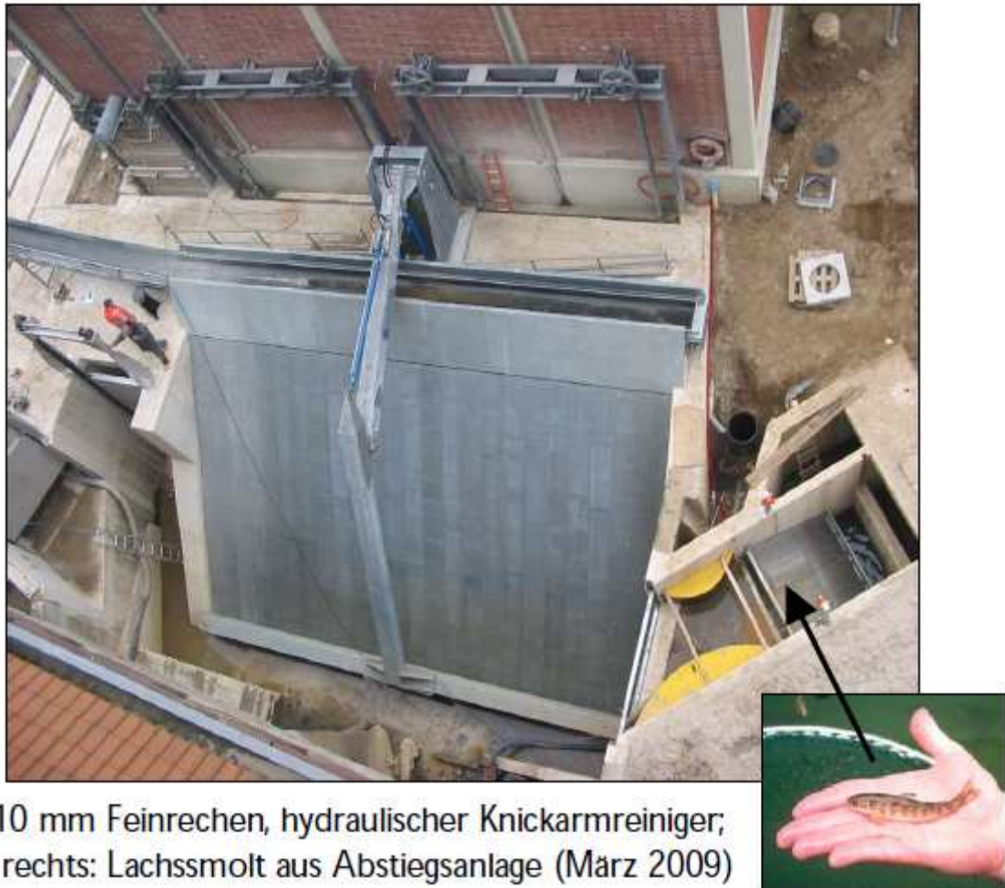
Figure 29 : Grilles fines (espacement inter-barreaux de 10 mm) de la centrale Roermond aux Pays-Bas.
