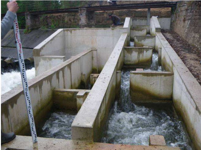
Figure 18 : Centrale de Lachapelle sur la Meurthe (54) (photo : V. BURGUN – ONEMA)
