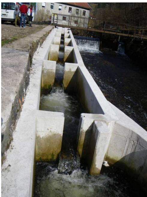
Figure 26 : Centrale des Zelles sur le Chajoux à la Bresse (88) (photo : V. BURGUN – ONEMA)
