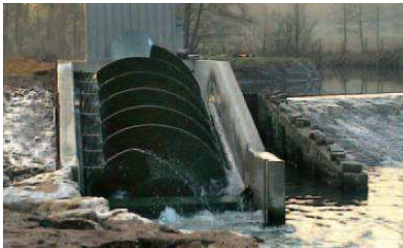
Figure 32 : Vis d'Archimède (Source Ritz-Atro)
