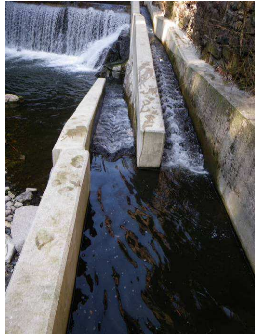
Figure 25 : Ralentisseurs de fond suractifs à Niederbruck sur la Doller (68) (photo : J. VIALARD – ONEMA)
