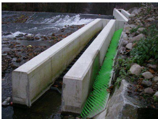
Figure 22 : Implantation de brosses à anguilles à Masevaux sur la Doller (68) (photo : P. BOHN – ONEMA)
