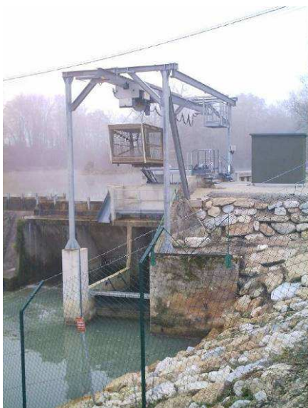
Figure 20 : Ascenseur de Precy-Saint-Martin (10) sur la Seine (photo D. MONNIER – ONEMA)
