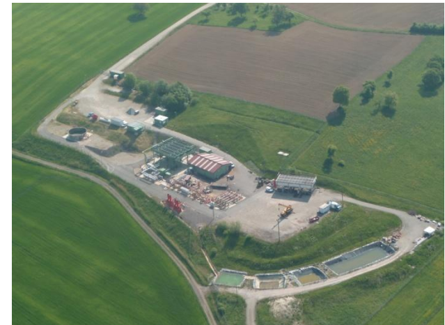
Site d'exploitation – bassins étanches
