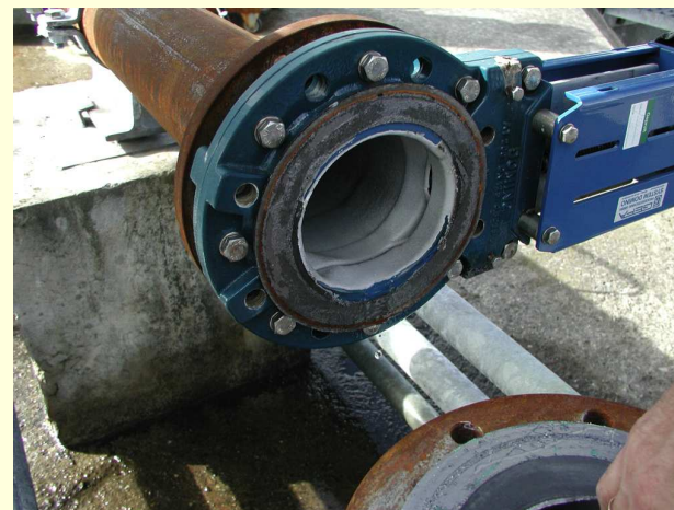
Bruchsal: Beschichtung Innenrohr
