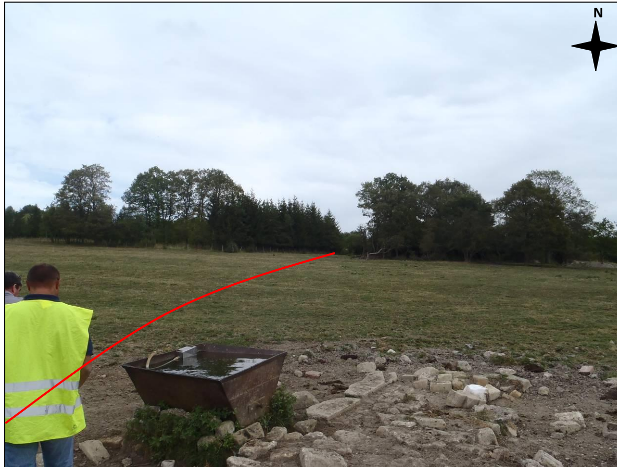
Figure 10 : Traversée des parcelles agricoles vers la zone à déboiser (axe sud-nord)
