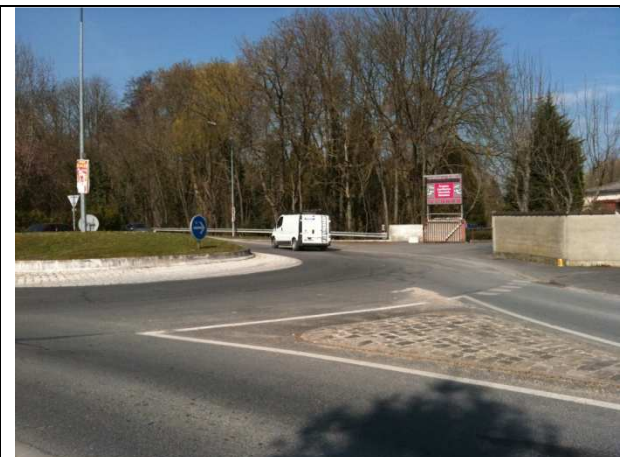
PHOTO N° 1 – DEPUIS GIRATOIRE RD75
