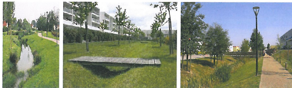
Des Noues Plantées qui permettront l'infiltration des eaux de pluies, un système économique et respectueux de l'environnement. Proposer Une gestion de l'eau à la parcelle.
