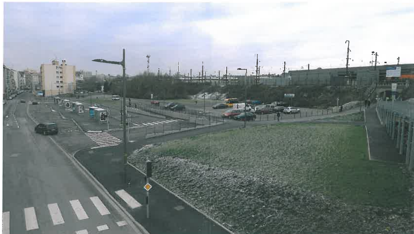
Vue vers le PEM et tunnel des arrivées
