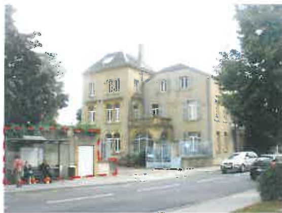
1 : Suppression du local transformateur et du mur d'enceinte+cloture
