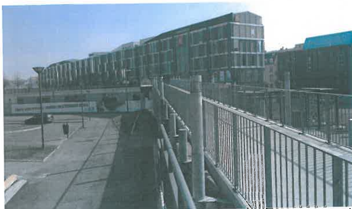
Vue n° 4 : Vue depuis la sortie du souterrain « Arrivées » sous les voies ferrées vers la passerelle conduisant au Parvis des Droits de l'Homme
