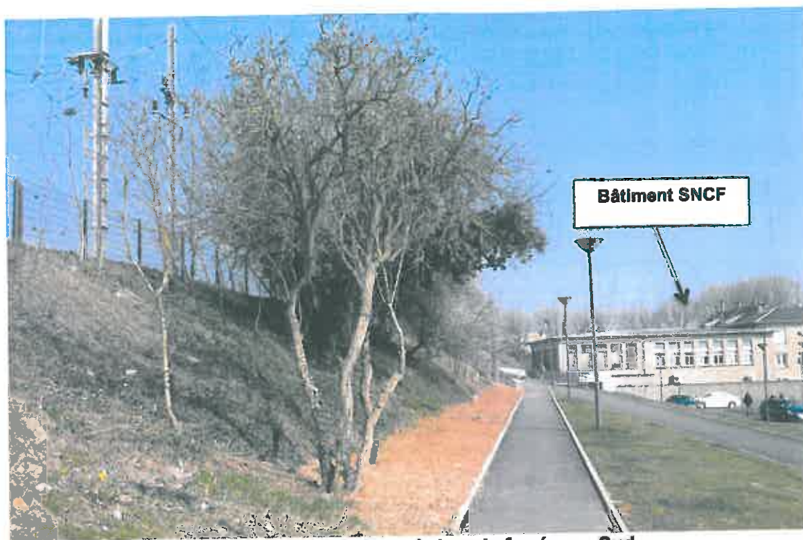
Vue n° 3 : Talus le long de la voie ferrée, au Sud
