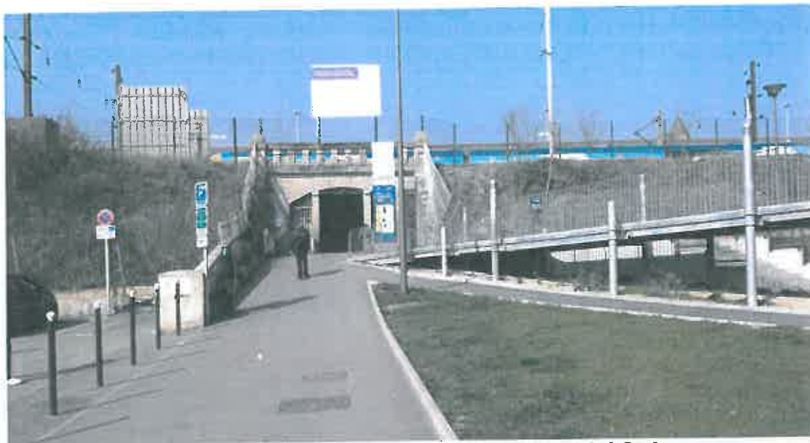
Vue n° 5 : Sortie du souterrain « Arrivées » côté Sud
