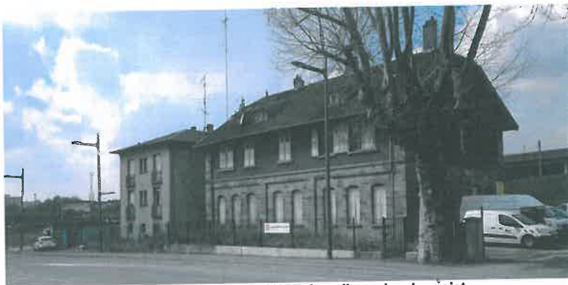
Vue n° 10 : Bâtiments SNCF dans l'emprise du projet
