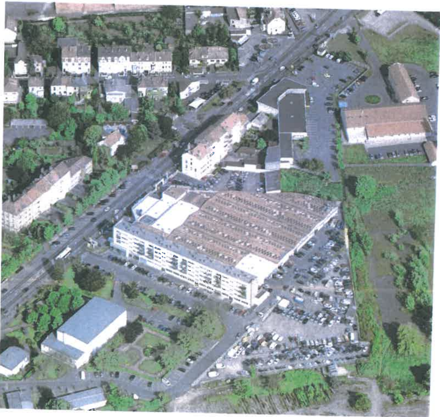
Vue du site avant travaux
