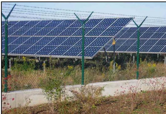
Figure 3 : Clôture de sécurité avec socle en maçonnerie (Photo : M. Reichmuth)
