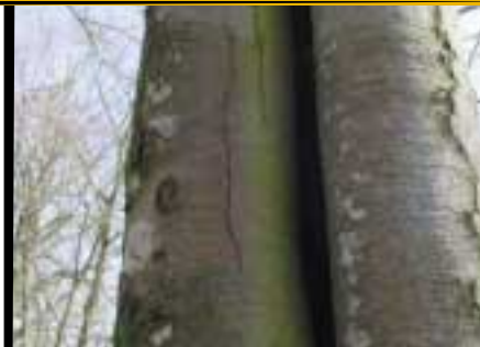
Les arbres fissurés sont à conserver
