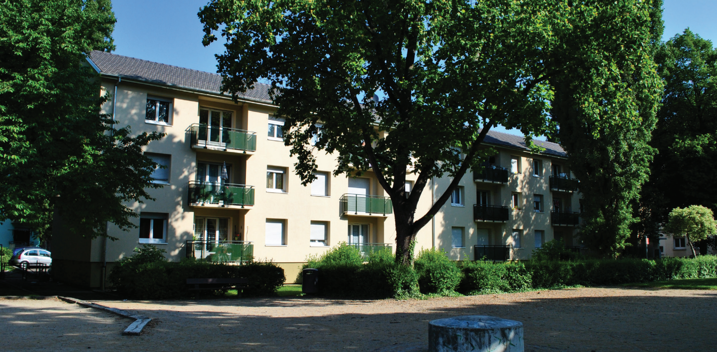
Résidence du quartier Sellier après réhabilitation - Crédit photo : Mulhouse Habitat
