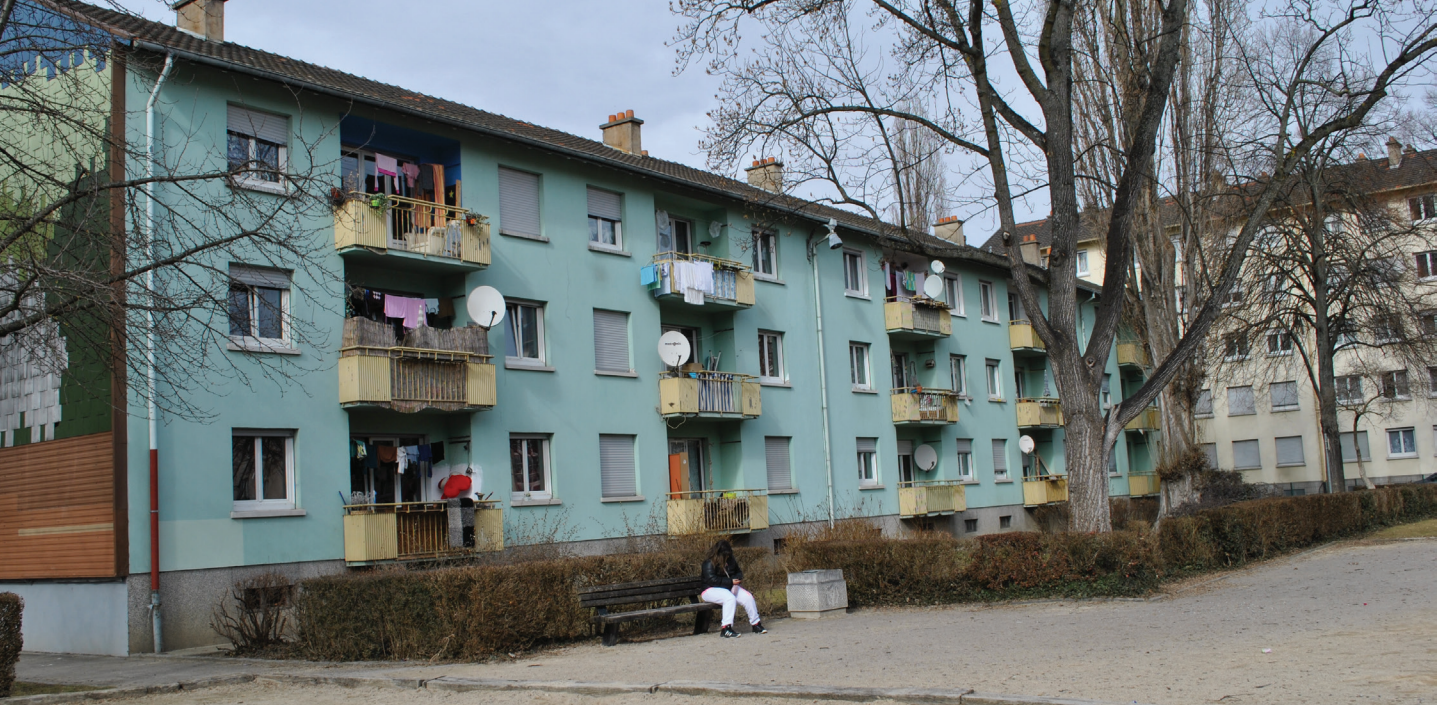
Résidence du quartier Sellier avant réhabilitation – Crédit photo : Mulhouse Habitat
