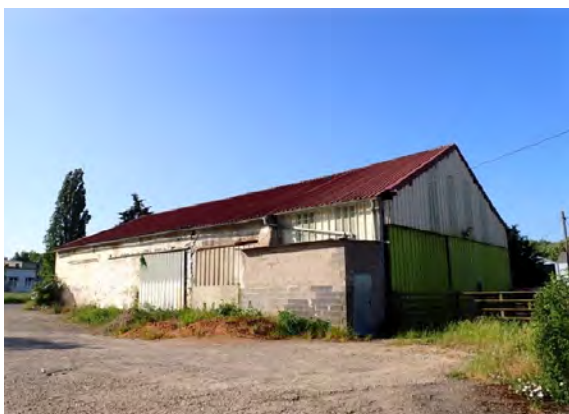
Bâtiments avec murs en pierre
