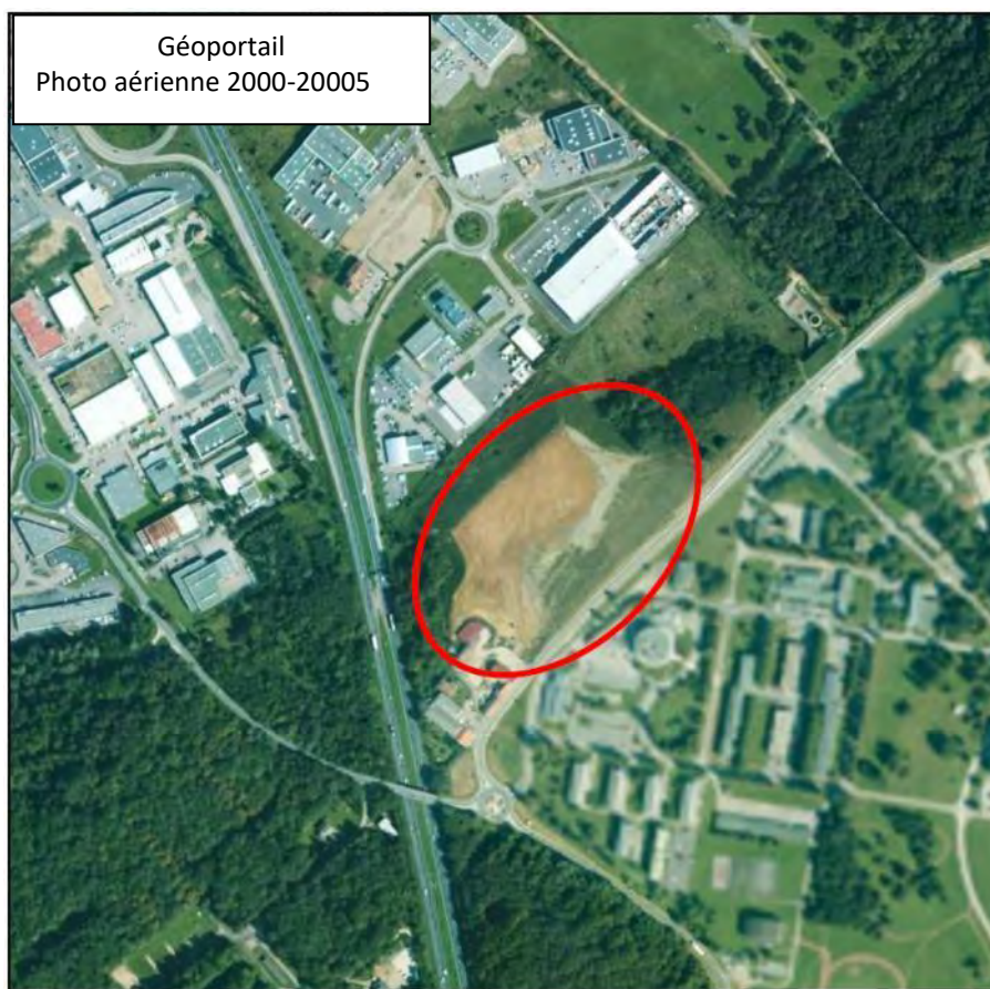
Figure 24 : photo aérienne de 2000-2005 (source : étude DTF géotechnique de février 2022)
