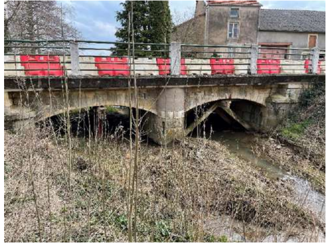
Ouvrage vue Aval
