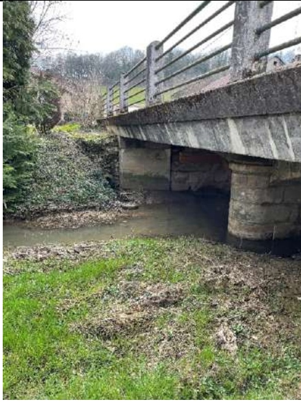
Ouvrage vue Amont
