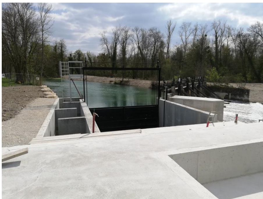
Photo 4 : Vue vers l'amont depuis la centrale (vannage à droite).
