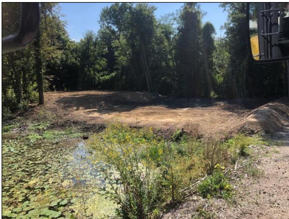
Photo 6 : Vue depuis la départementale sur le batardeau lors des travaux de 2018-2019 et colonisation amont par des marcophytes.
