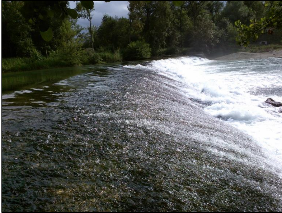
Photo 1 : Vue de la rive droite du barrage amont.
