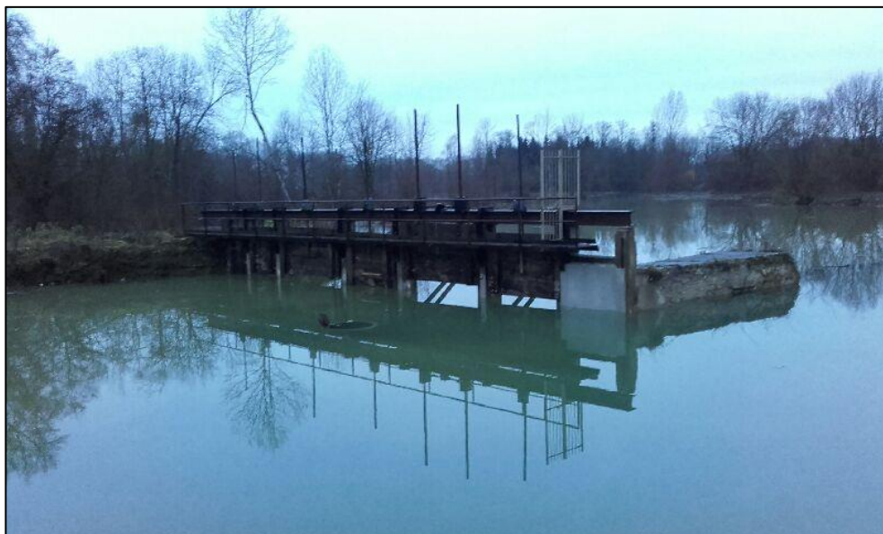
Photo 7 : Vannage et bief sous crue en janvier 2018.
