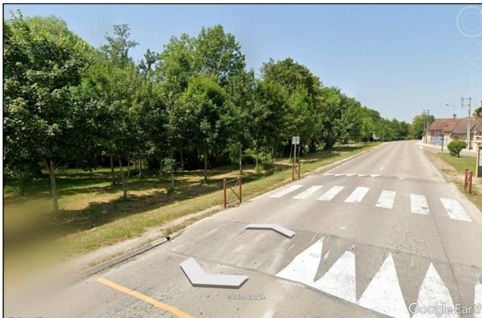
Photo 5 : Vue depuis la départementale de la rive droite du canal d'aménée.
