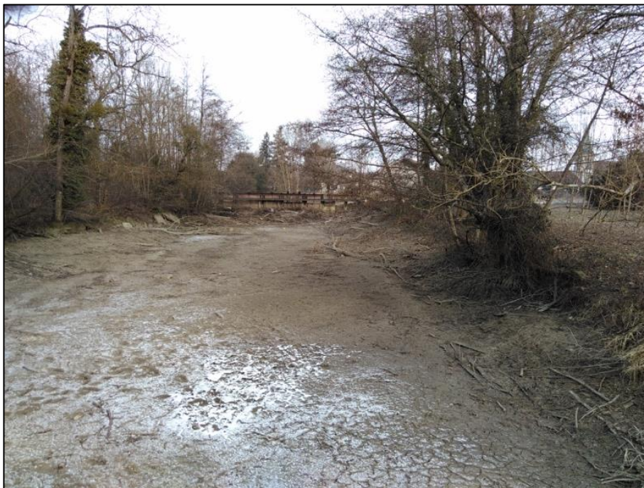
Photo 2 : Mise à sec amont du vannage (canal d'amenée) en 2017-2018.
