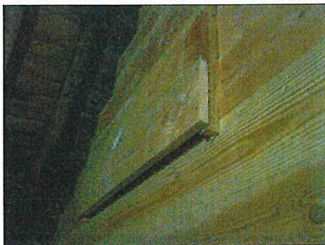
Figure 20 : Pose de micro-gîtes
