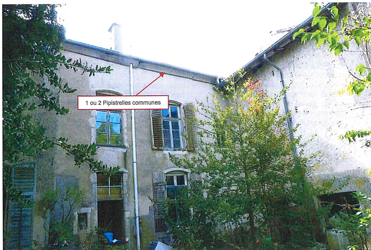
Figure 12 : Localisation des chiroptères en sortie de gîte le 14/09/2020 au niveau du presbytère
