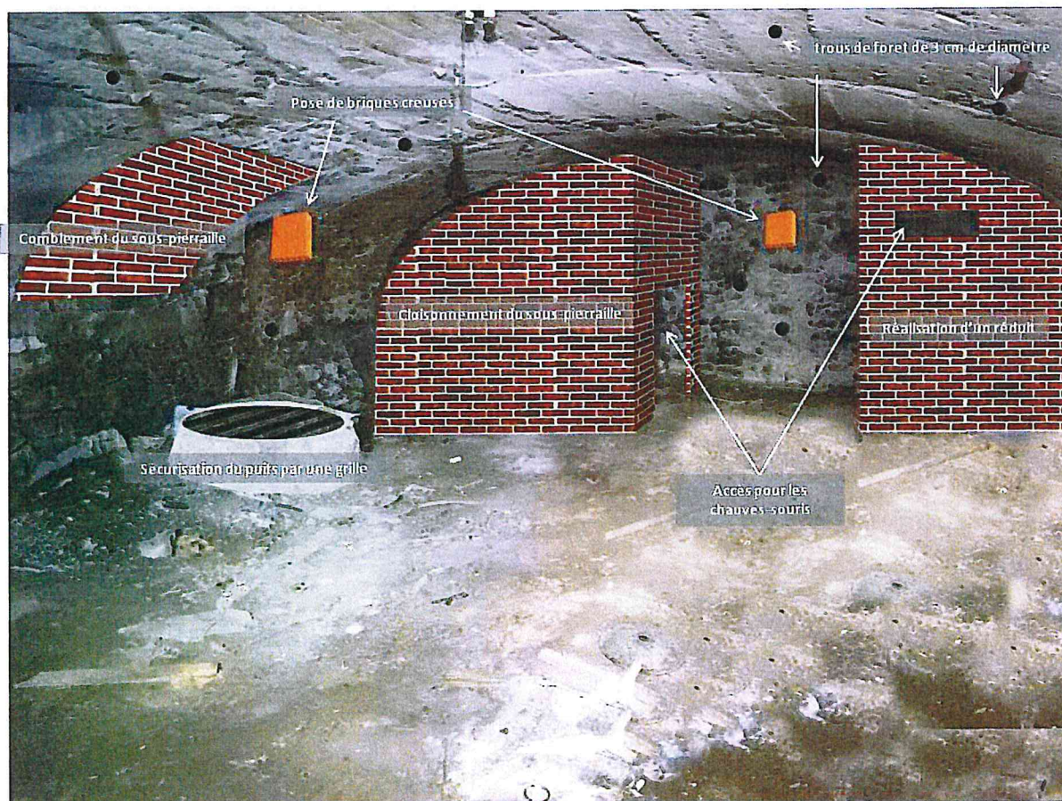
Figure 19 : Représentation schématique des aménagements dans la cave du Presbytère
