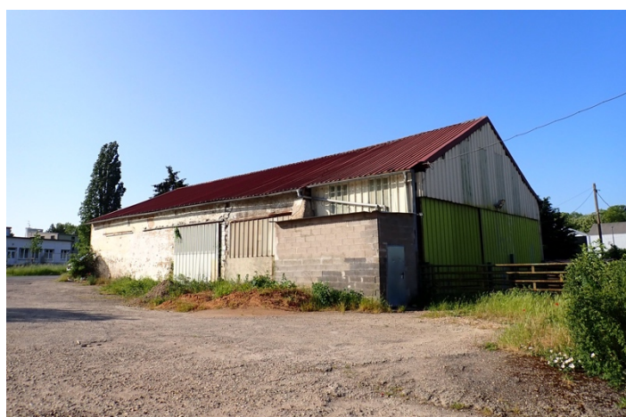
Bâtiment agricole en mai 2023
