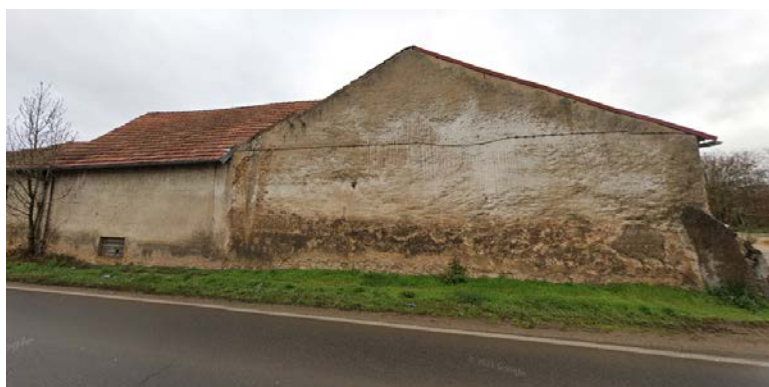
Façade sud du bâtiment agricole
