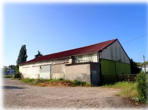
Bâtiments avec murs en pierre
