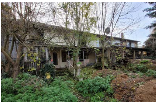
Façade nord de la maison d'habitation
