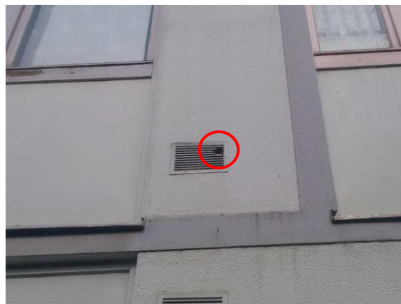
Trou dans une grille d'aération permettant la nidification de couples de moineaux domestique Source : LPO
