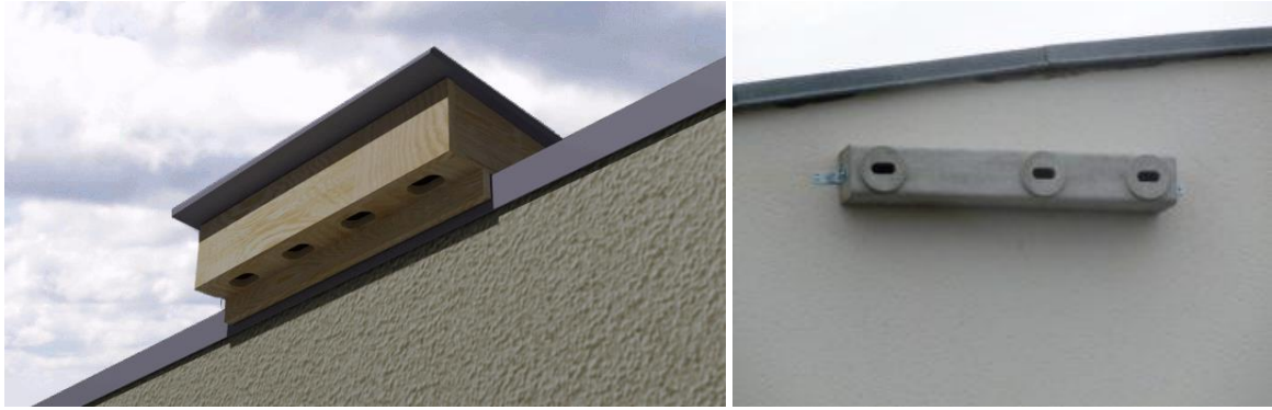
Exemple de nichoir installé en débord de toit (à gauche) et en façade (à droite) Source : LPO
