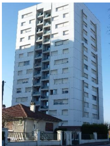
Immeuble Les Pics Verts Source : Vitry Habitat
