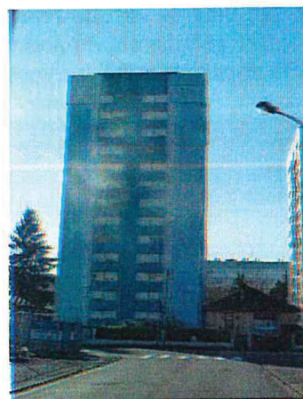
Immeuble Les Tourterelles Source : Vitry Habitat
