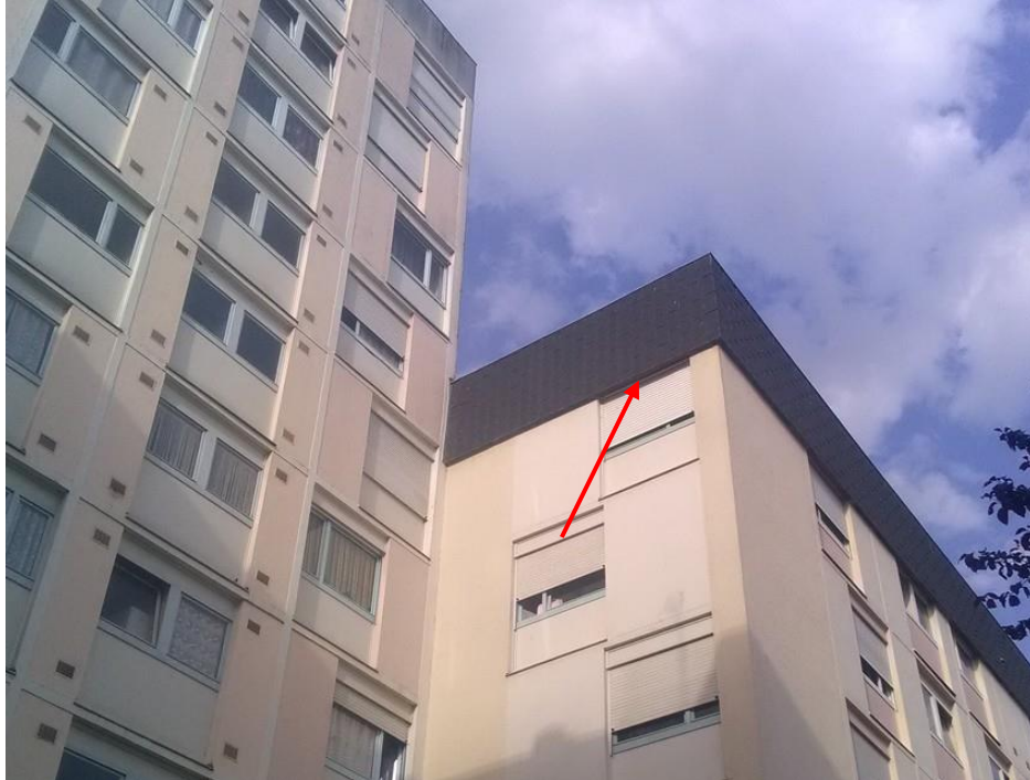
Figure 5 : Revêtement de toiture sur « Les Hérons » abritant un couple de Martinet noir
