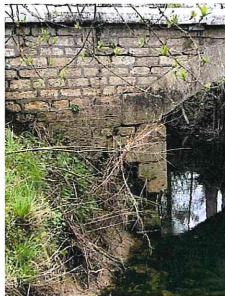
Chaîne d'angle Aval rive Droite manquante
