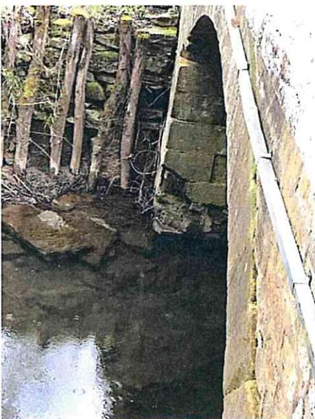
Chaîne d'angle Amont rive Gauche dégradée
