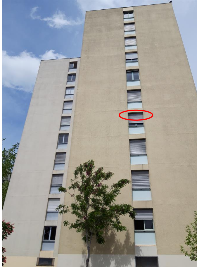
Figure 2 : Façade sud du bâtiment n°7 (Sarcelles) dans lequel une colonie de 36 Pipistrelles communes à été localisée dans le volet roulant du 4 ème étage
