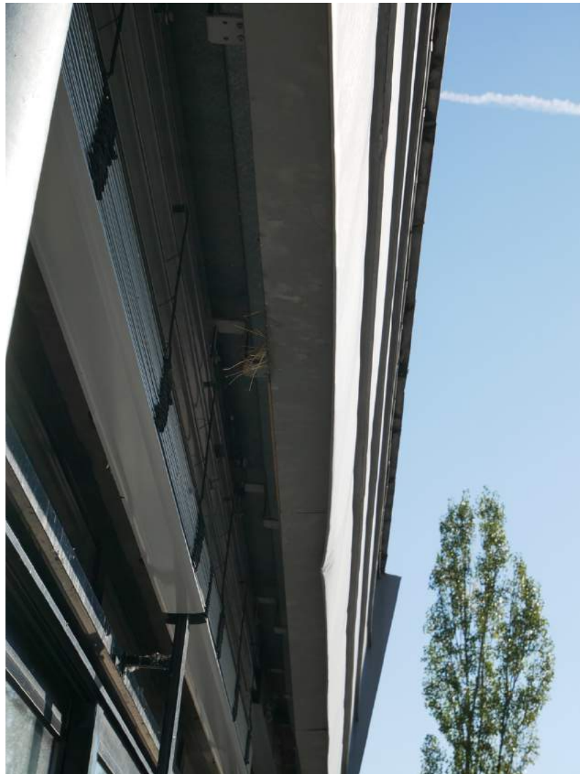
Brise-soleil et support de fixation
