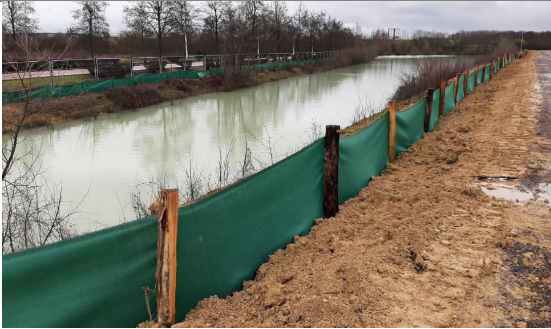
Figure 5 : Balisage des berges du bassin 3 sur le site ©IDEC,2023
