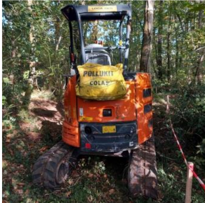
Figure 8: Kit anti-pollution sur un chantier de mesures compensatoires près d'Angers
