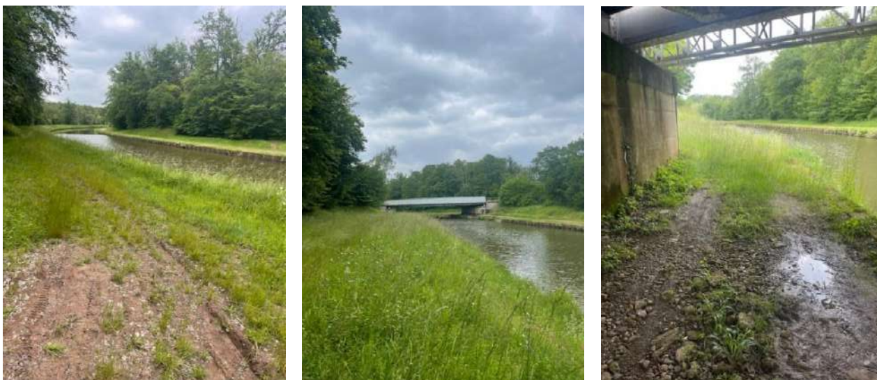
Figure 11 : Vues du chemin de halage à emprunter pour l'accès en véhicule
