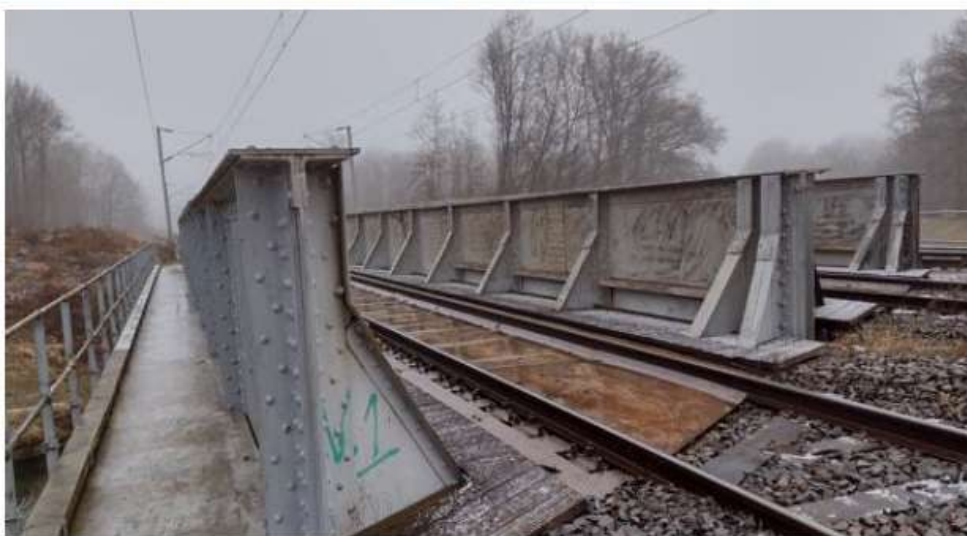
Figure 2: Photographie du pont rail existant
